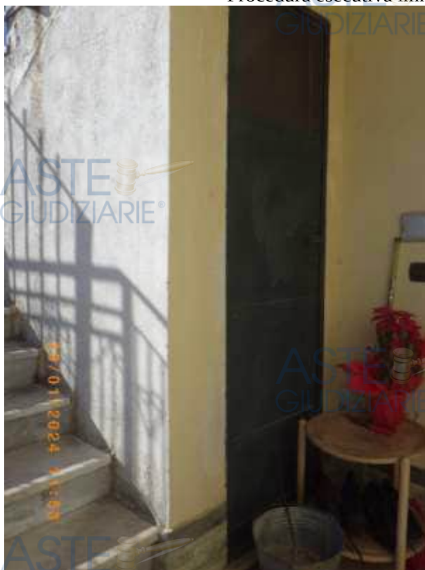
Foto 26. Vano sottoscala esterno
