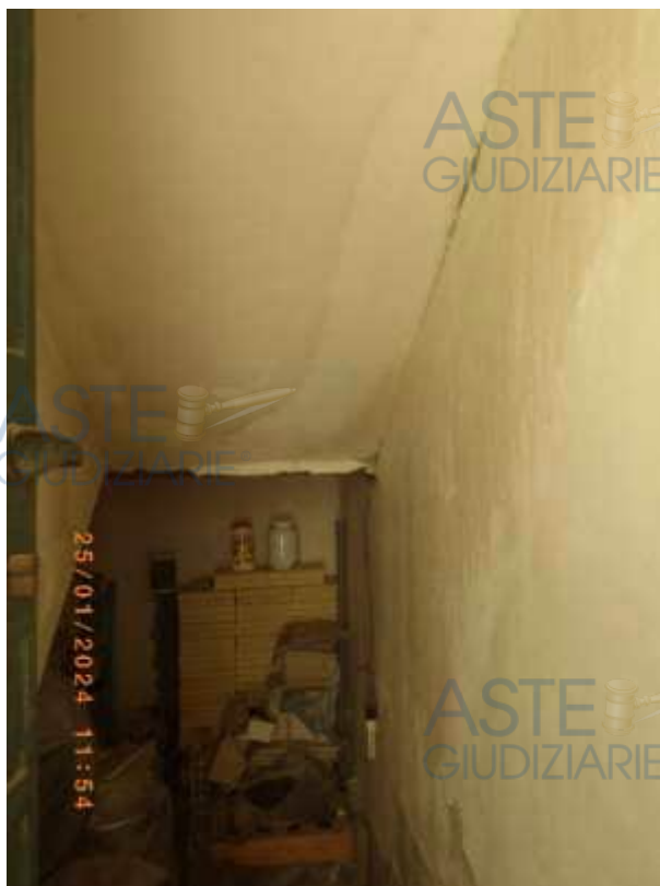
Foto 27. Vano sottoscala interno
