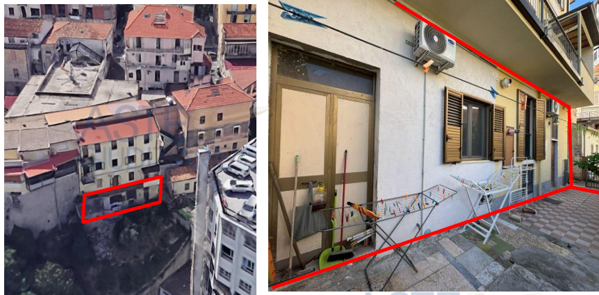
Figura 2 e 3 : Viste prospetto NORD del fabbricato da Strada comunale per Siano e particolare
