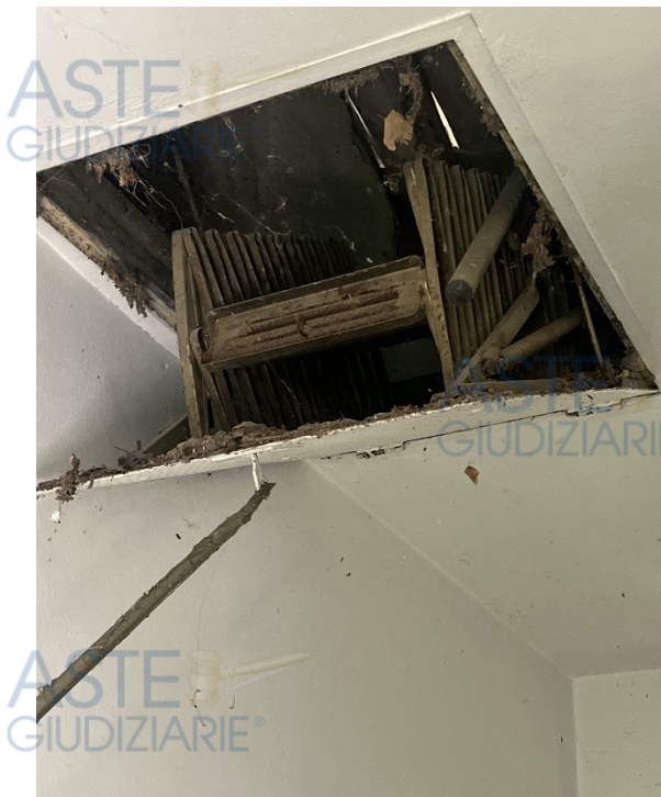
Botola di accesso al sotto tetto
