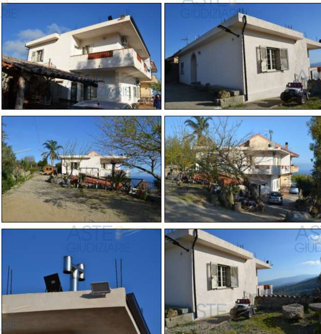
Figura 14 - Vista di insieme del fabbricato
