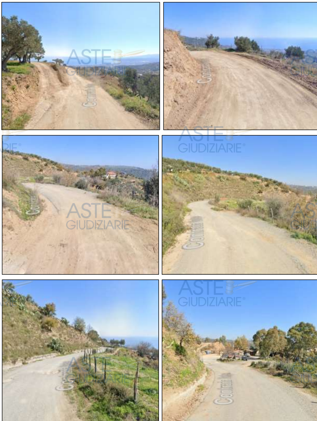
Figura 7 - Strada di accesso al fabbricato
