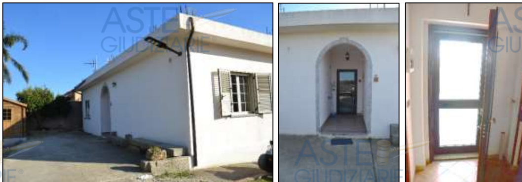
Figura 21 - Ingresso al BENE B
