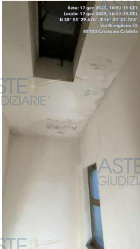
Foto 31. Tracce di infiltrazioni ed umidità all' interno del vano scala
