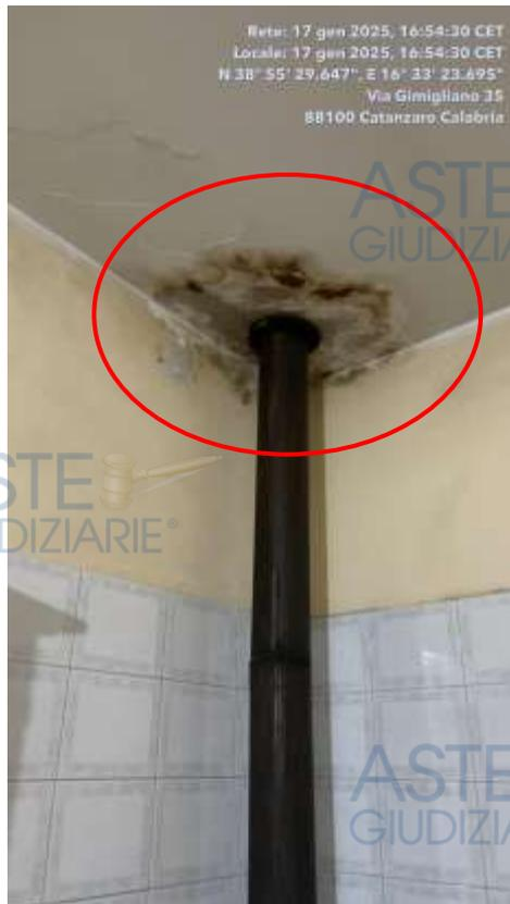
Foto 19. Particolare innesto canna fumaria stufa nel solaio
