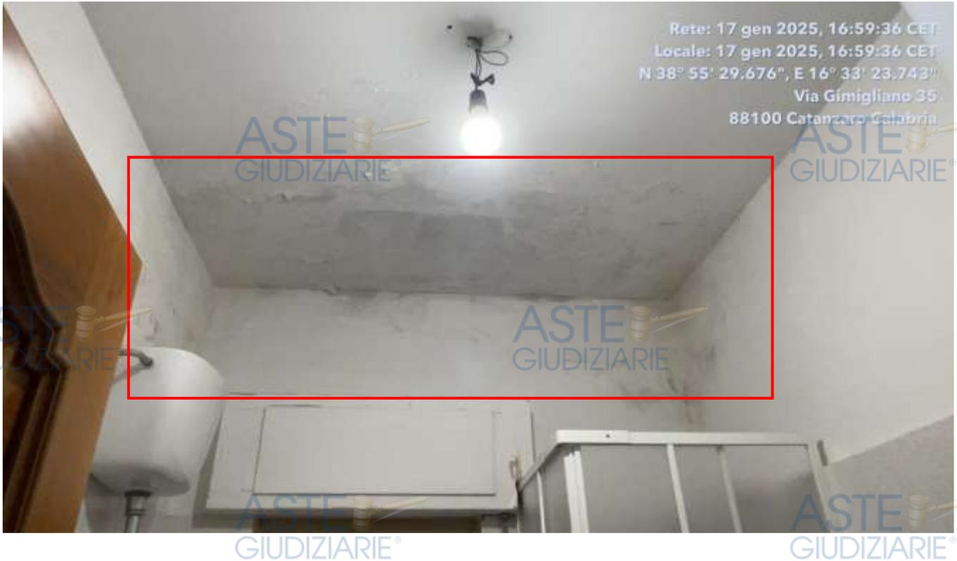
Foto 14. Particolare macchia di umidità e/o infiltrazioni dalla sovrastante copertura
