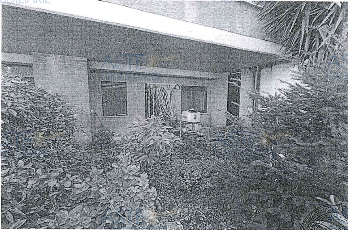
Foto 1 – Vista dal giardino
