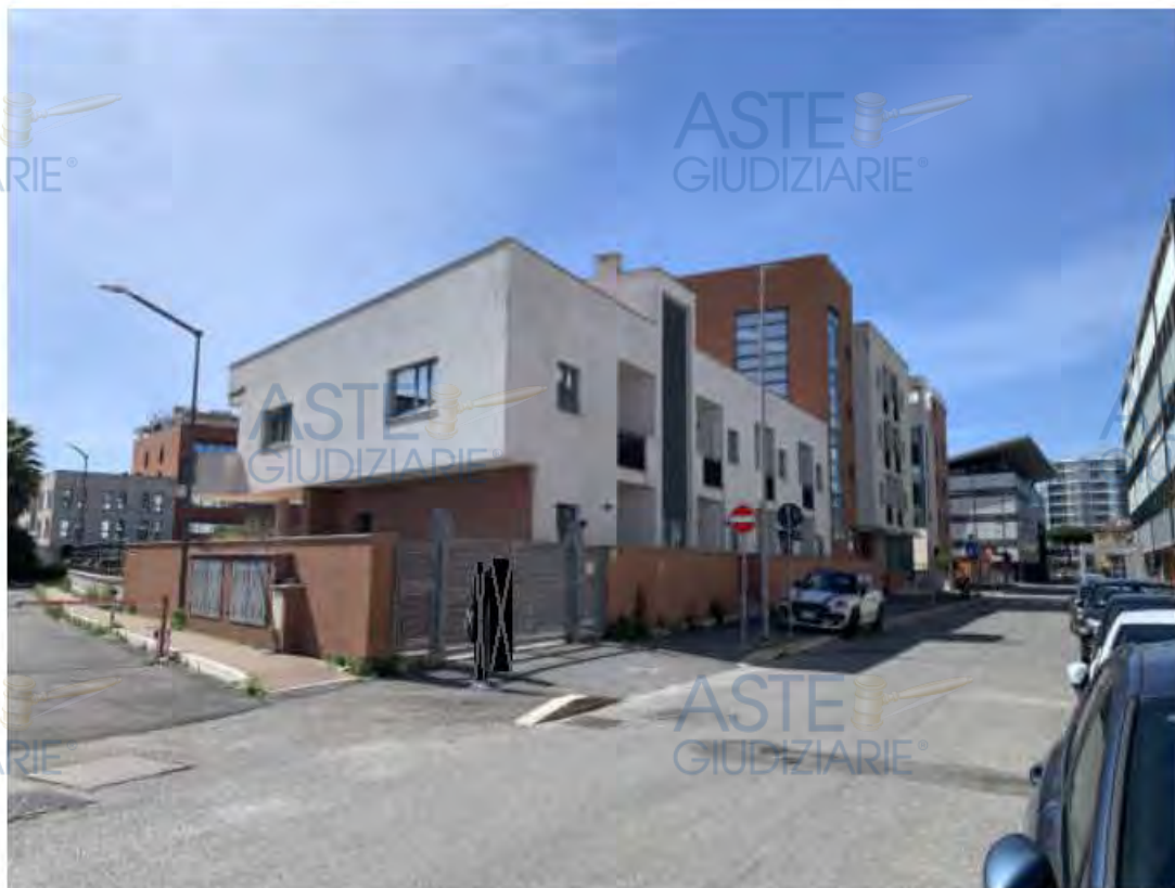
Foto N. 2: particolare verso l'ingresso carraio condominiale della palazzina da Via E.Berlinger
