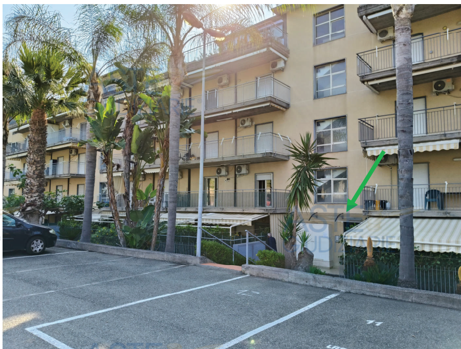
Figura 7- Visualizzazione dell'edificio condominiale e dell'ingresso al vano scala dello stabile condominiale
