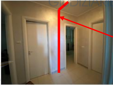
3. Rimozione tramezzo e 5a. ampliamento del corridoio
