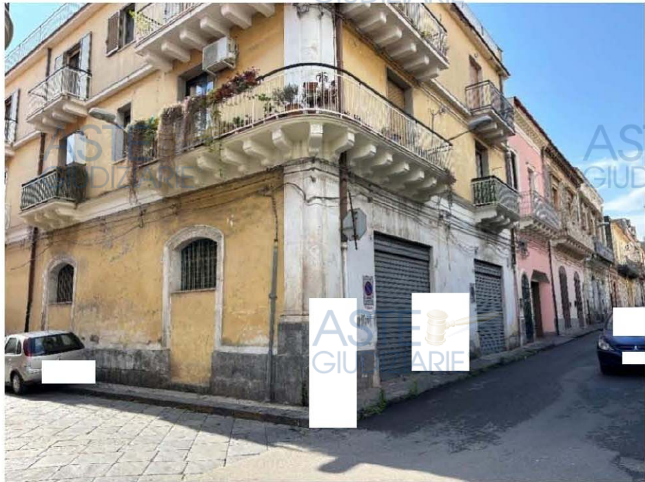
Immagine 13 – foto d'angolo del prospetto fra via Carolina e Via Dante
