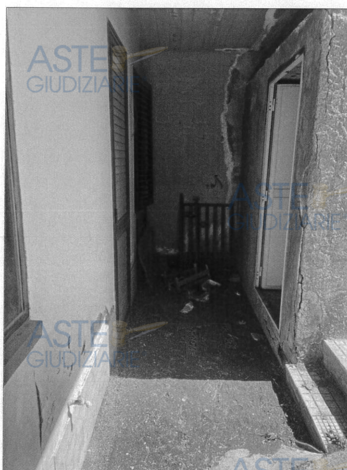
Area antistante il piano interrato
