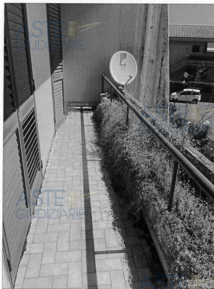
Balcone al piano primo
