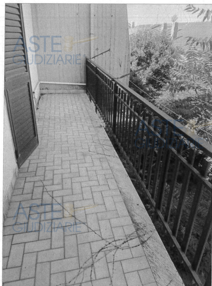
Balcone al piano primo
