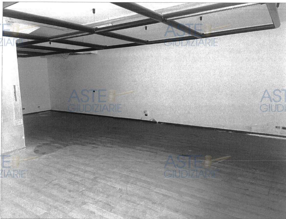
Vano al piano interrato
