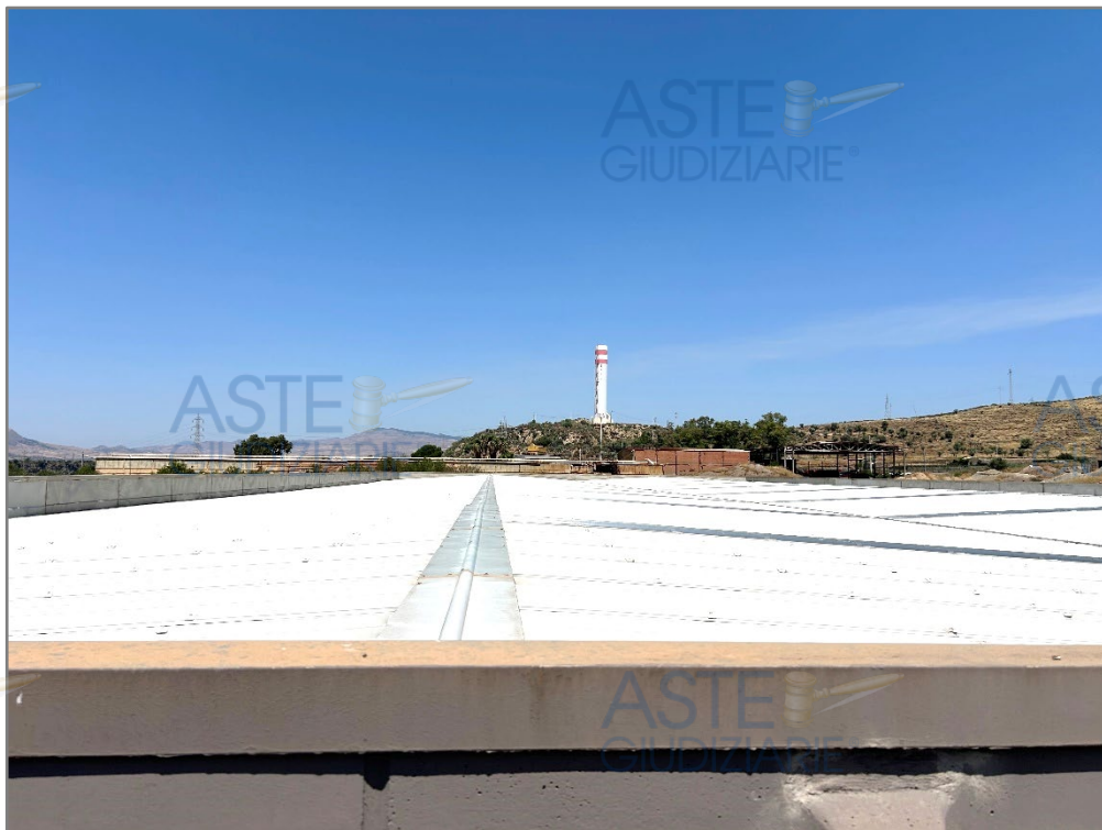
Figura 4: Estradosso della copertura - Lastrico solare
