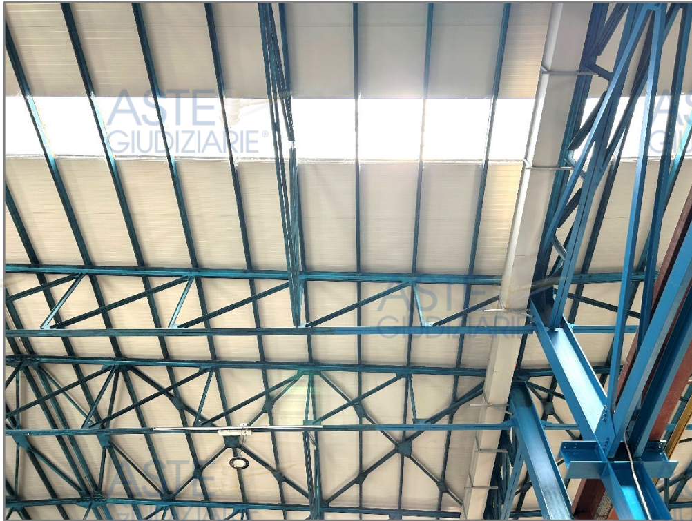
Figura 3: Intradosso della copertura
