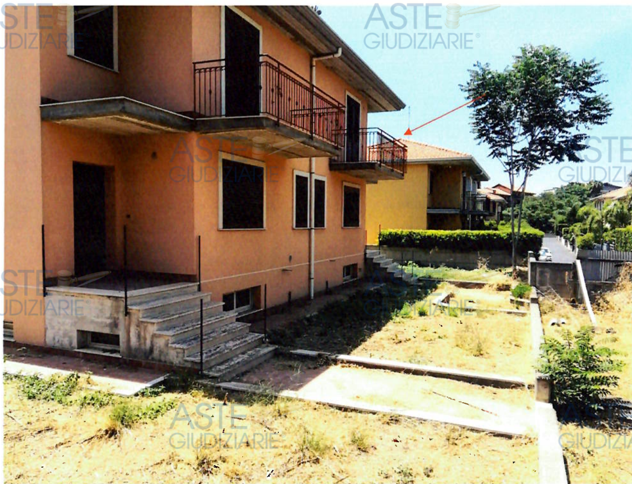
Foto n. 9- Visualizzazione del prospetto nord dell'immobile
