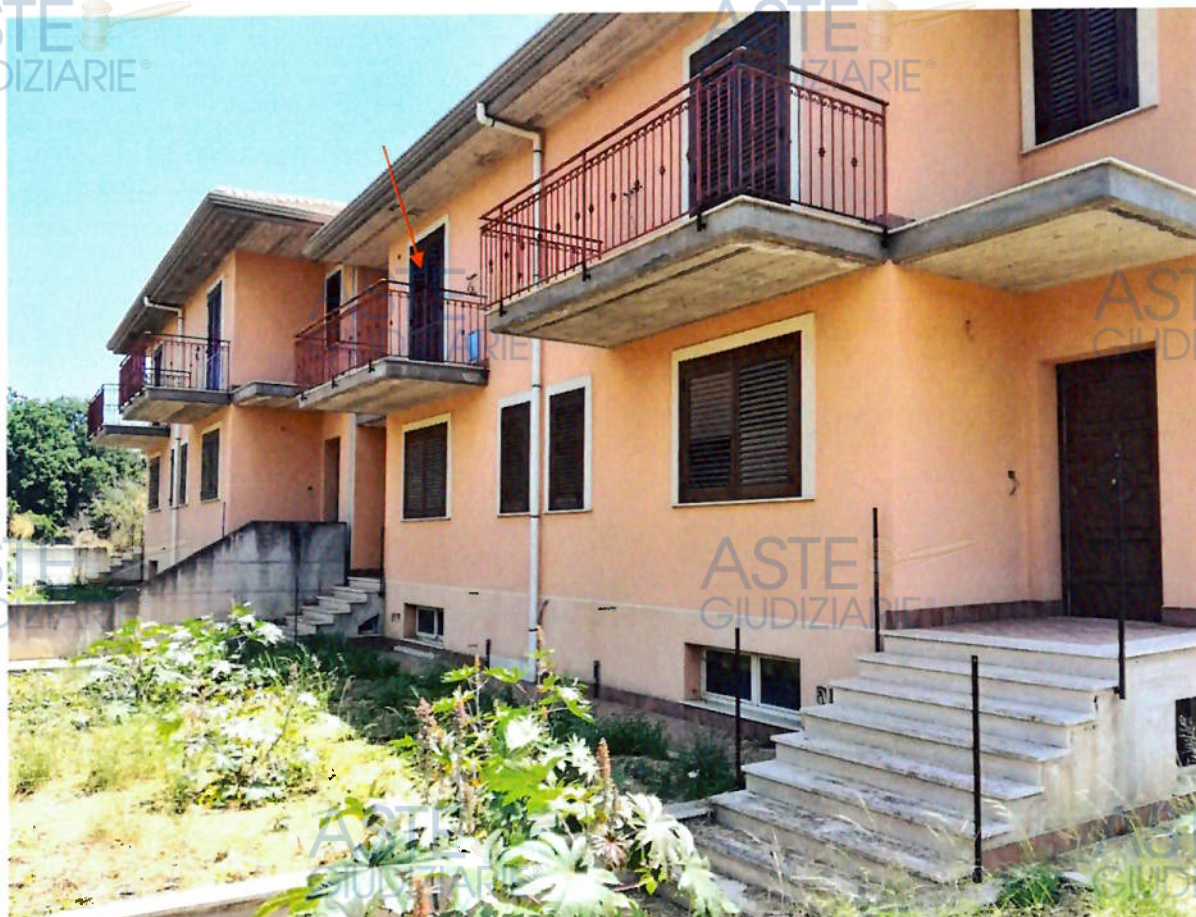
Foto n. 10- Visualizzazione del prospetto nord dell'immobile
