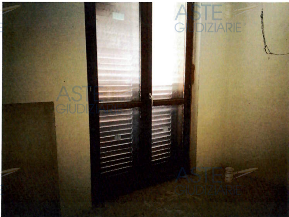
Foto n. 9- Visualizzazione del vano a piano primo
