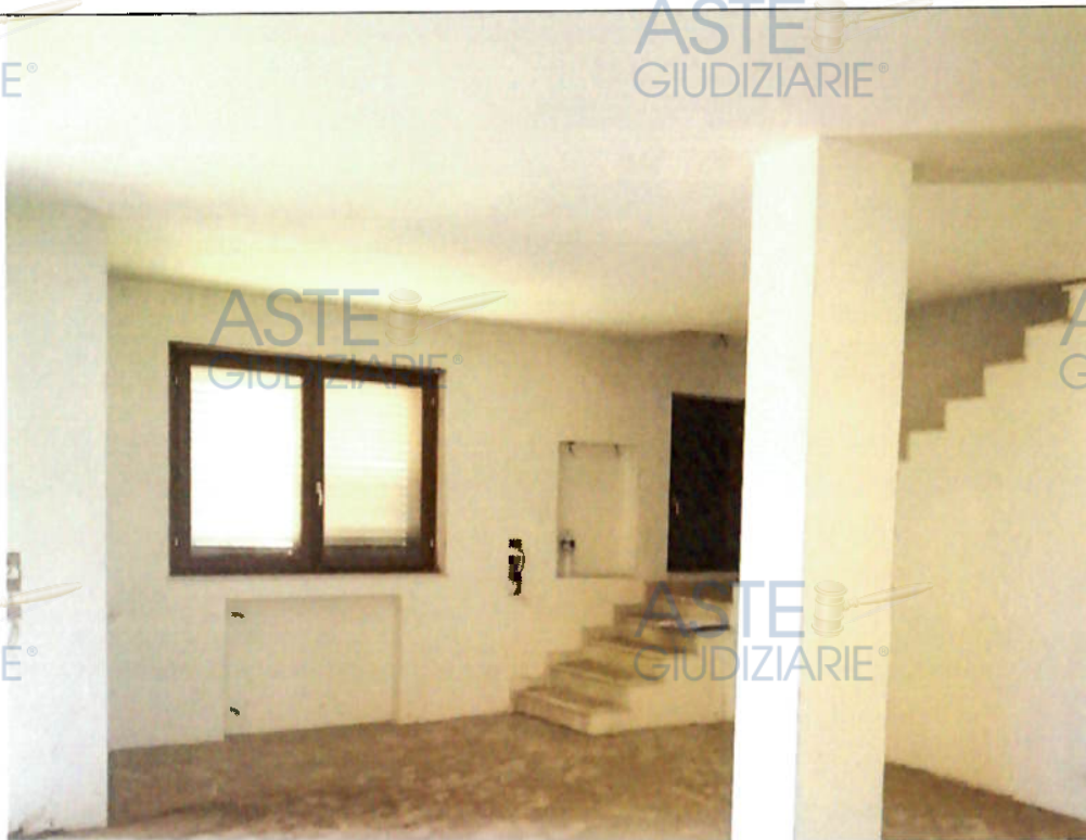
Foto n. 2- Visualizzazione del vano a piano terra
