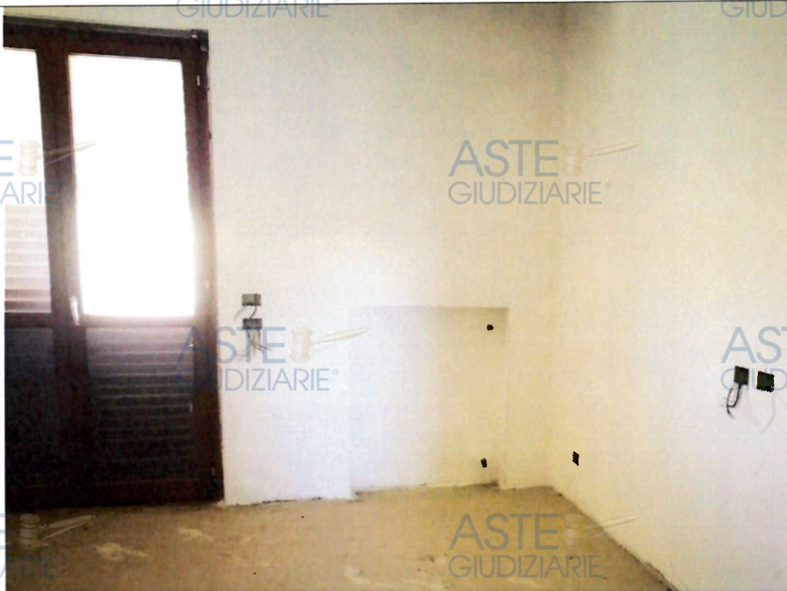
Foto n. 5- Visualizzazione del vano a piano primo
