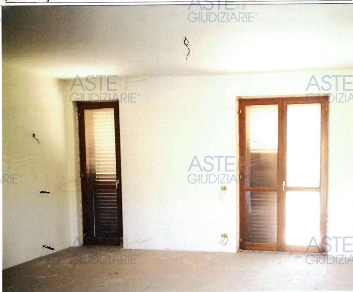
Foto n. 5- Visualizzazione del vano a piano terra
