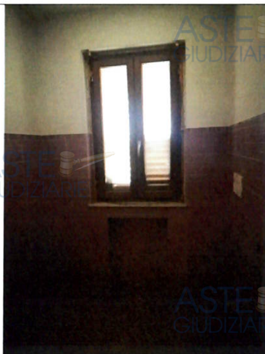
Foto n. 7- Visualizzazione del bagno a piano primo
