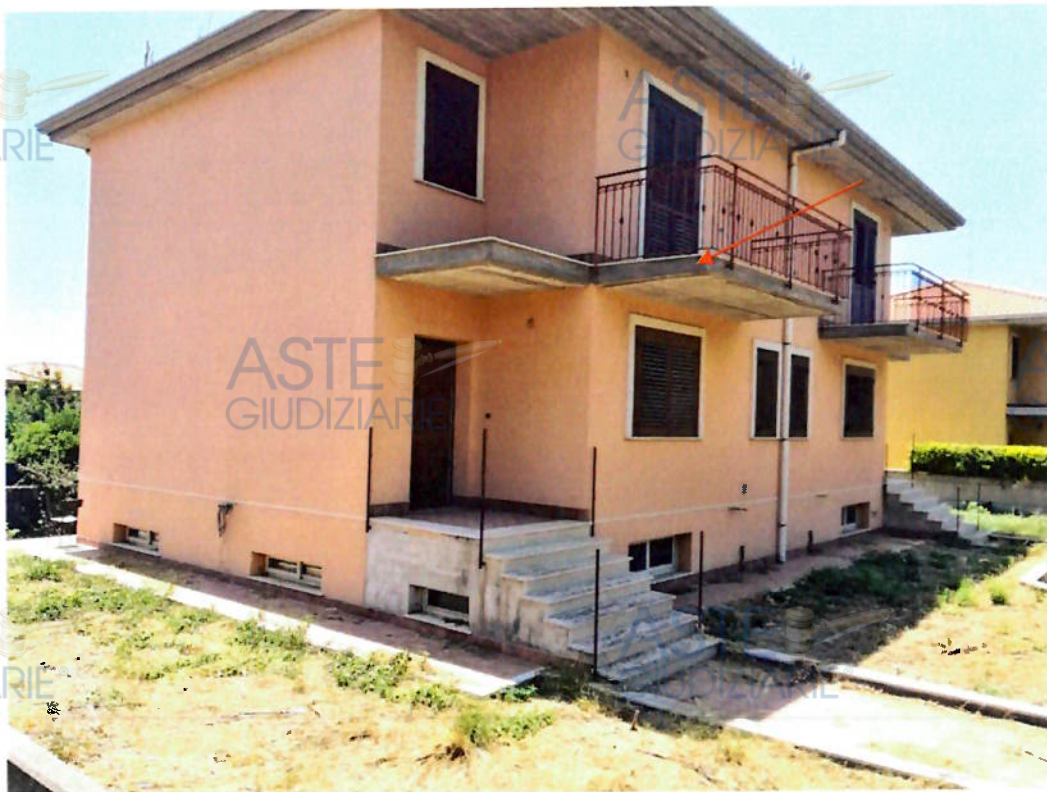
Foto n. 9- Visualizzazione del prospetto nord dell'immobile
