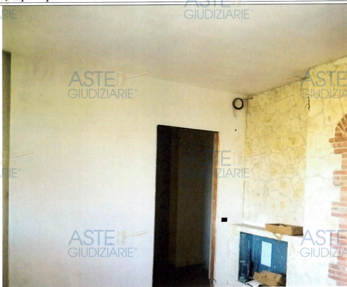
Foto n. 2- Visualizzazione del vano a piano terra
