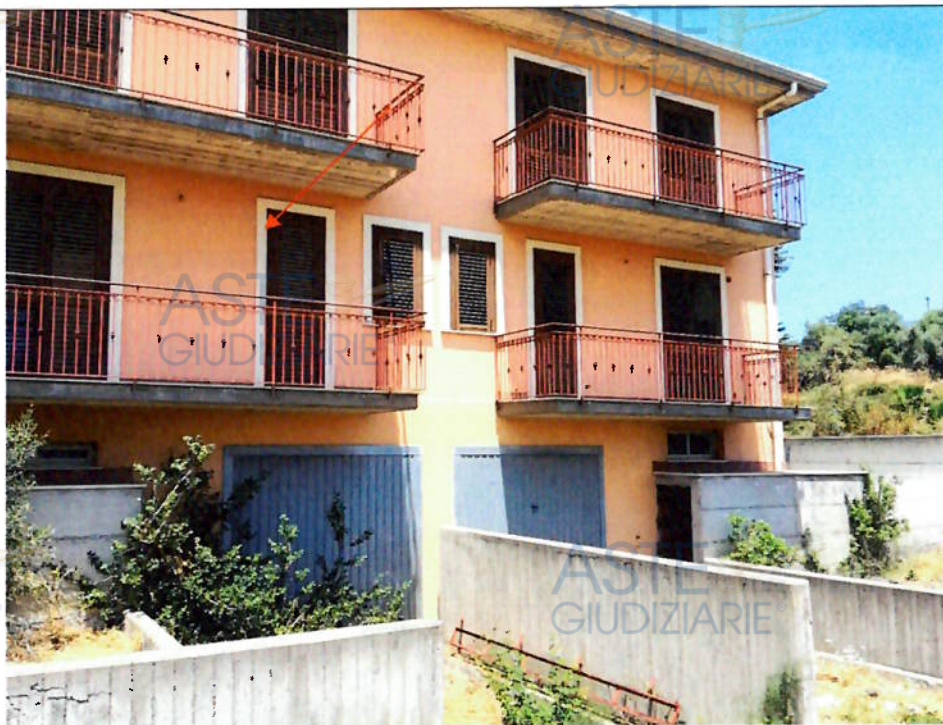
Foto n. 8- Visualizzazione del prospetto nord dell'immobile
