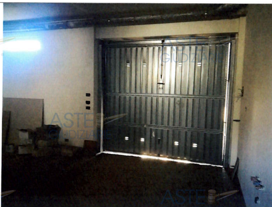
Foto n. 5- Visualizzazione della saracinesca di ingresso al garage
