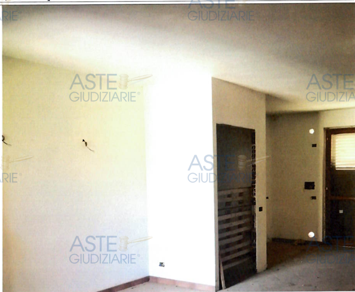
Foto n. 4- Visualizzazione del vano a piano terra
