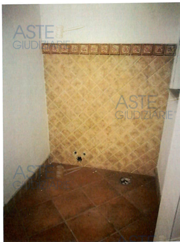
Foto n. 3- Visualizzazione del bagno a piano terra
