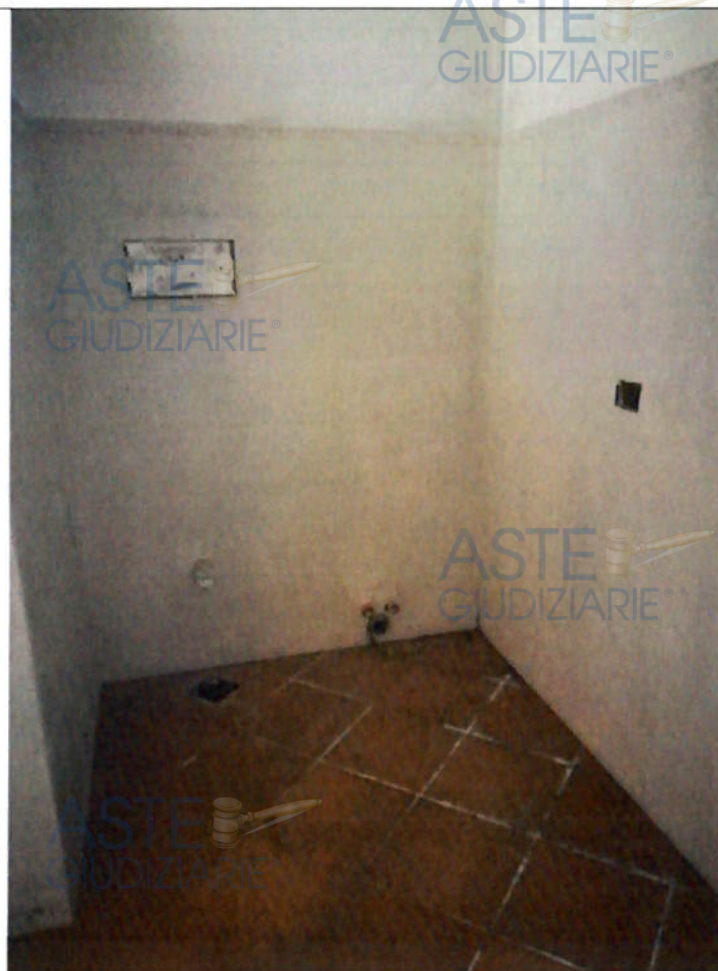
Foto n. 6- Visualizzazione del bagno a piano cantinato
