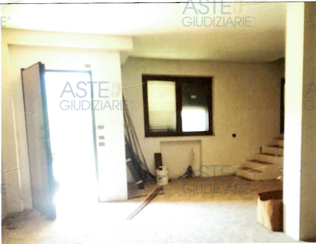
Foto n. 6- Visualizzazione del vano a piano terra
