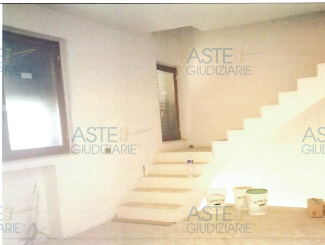
Foto n. 5- Visualizzazione del vano a piano terra
