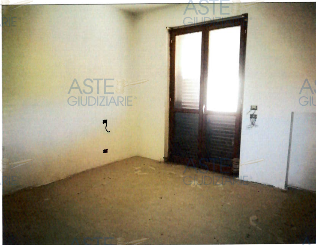
Foto n. 6- Visualizzazione del vano a piano cantinato
