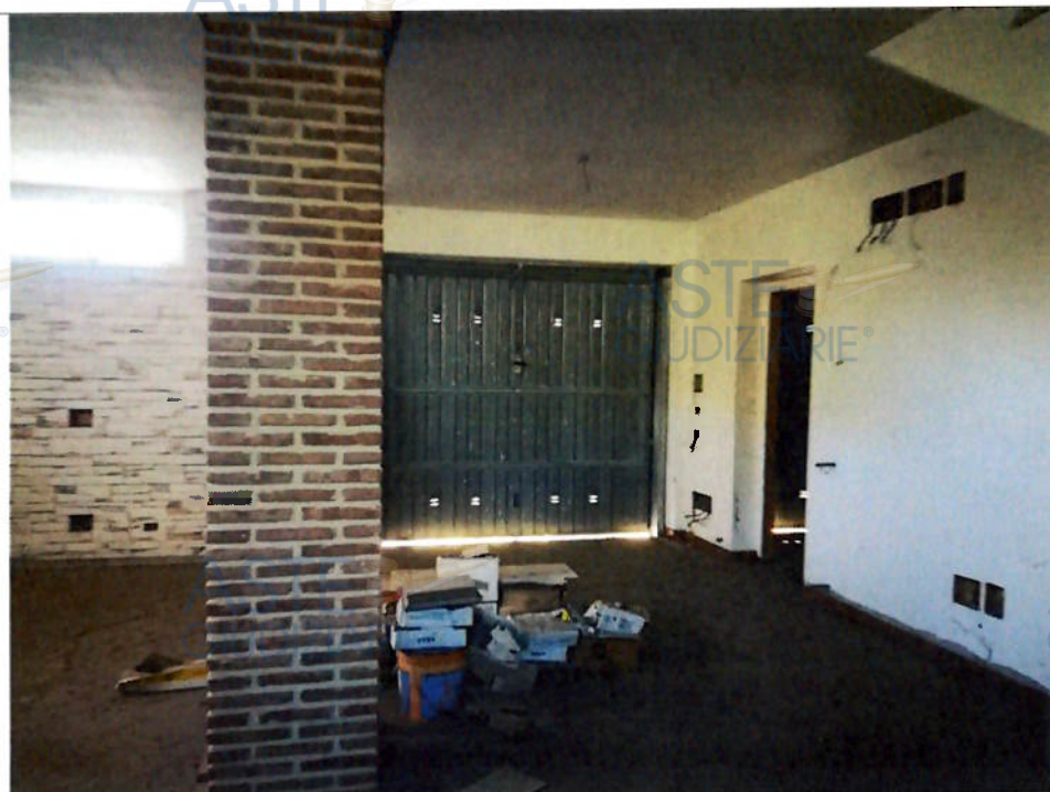
Foto n. 5- Visualizzazione del vano a piano cantinato
