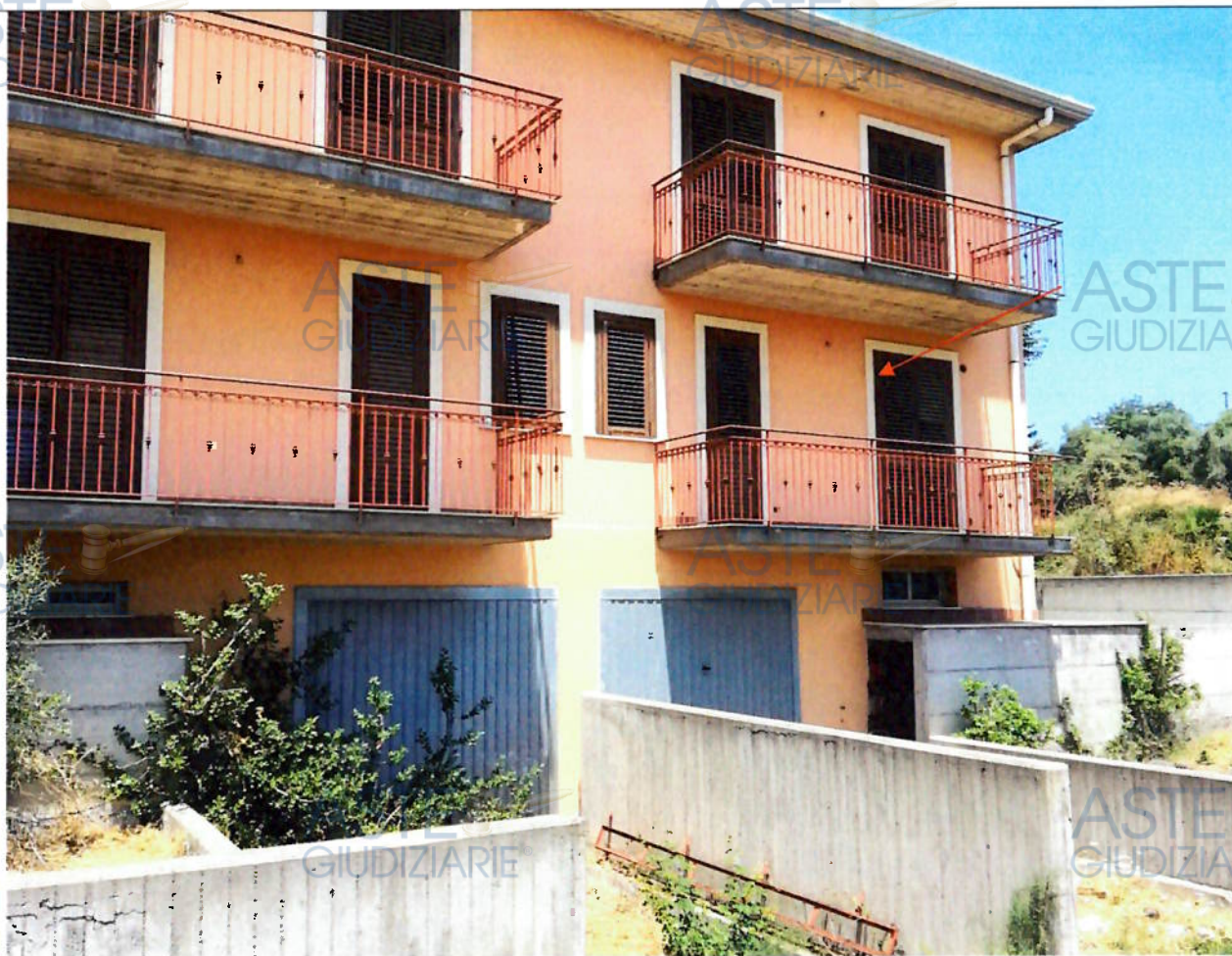
Foto n. 11- Visualizzazione prospetto sud dell'immobile
