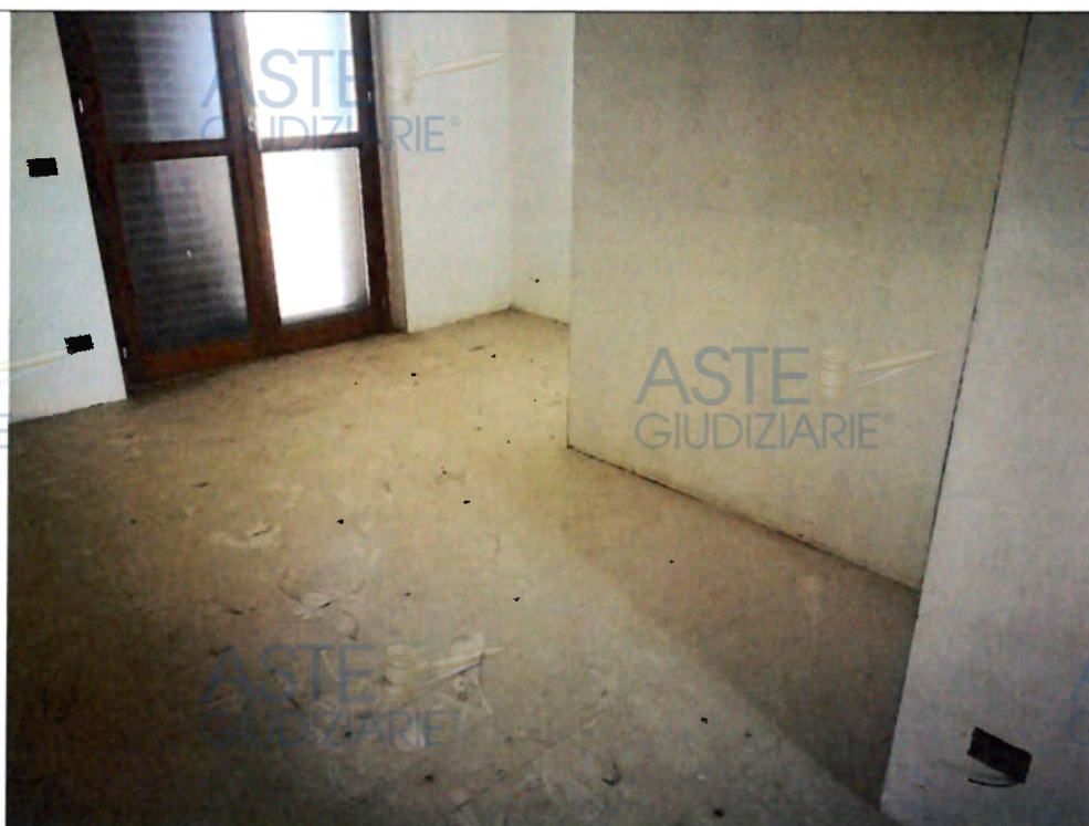
Foto n. 8- Visualizzazione del vano a piano primo
