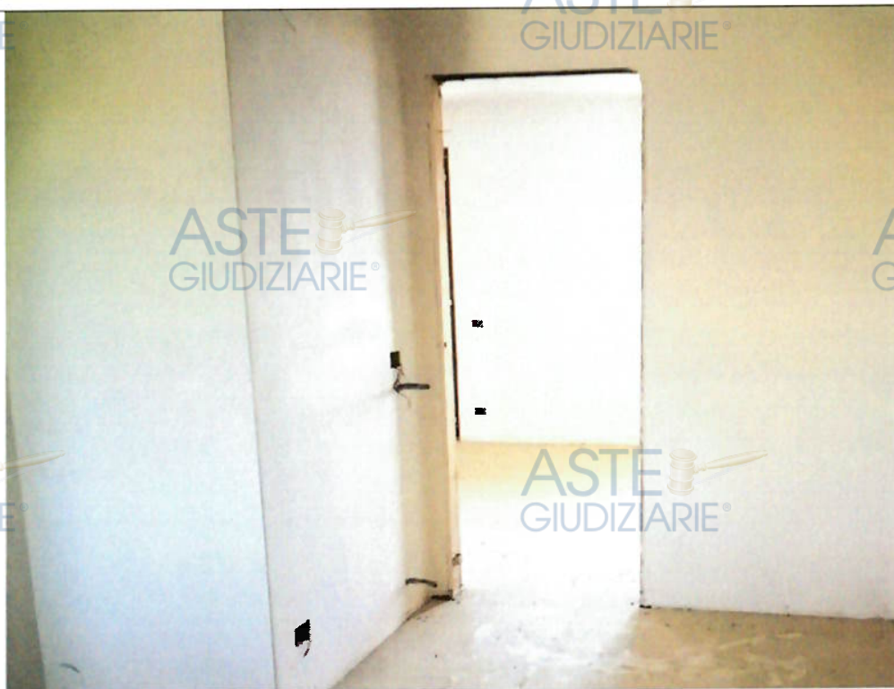
Foto n. 9- Visualizzazione del vano a piano primo
