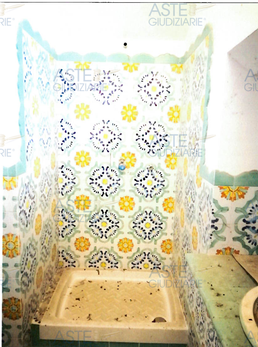
Foto n. 6- Visualizzazione del bagno a piano cantinato
