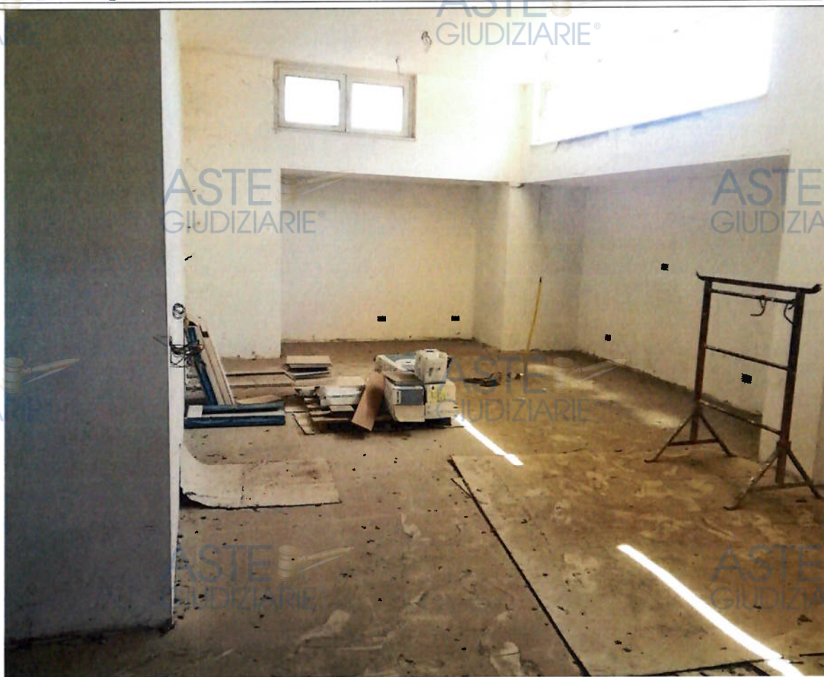
Foto n. 3- Visualizzazione del vano a piano cantinato
