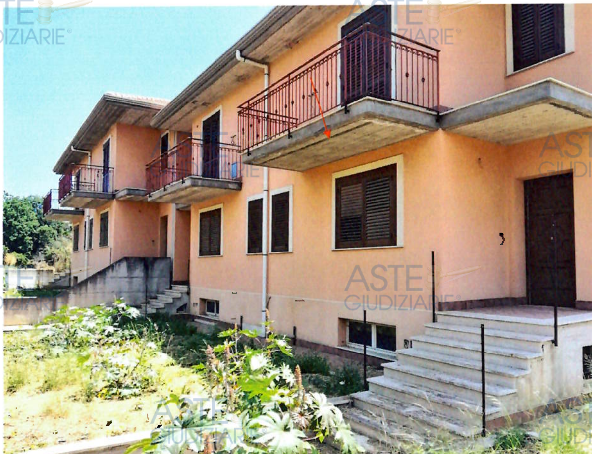
Foto n. 10- Visualizzazione del prospetto nord dell'immobile
