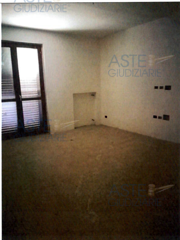
Foto n. 7- Visualizzazione del vano a piano primo
