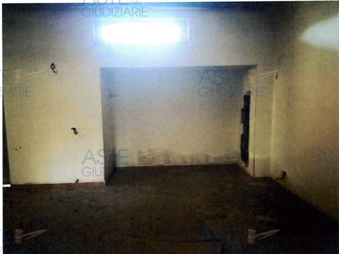
Foto n. 3- Visualizzazione del vano a piano cantinato
