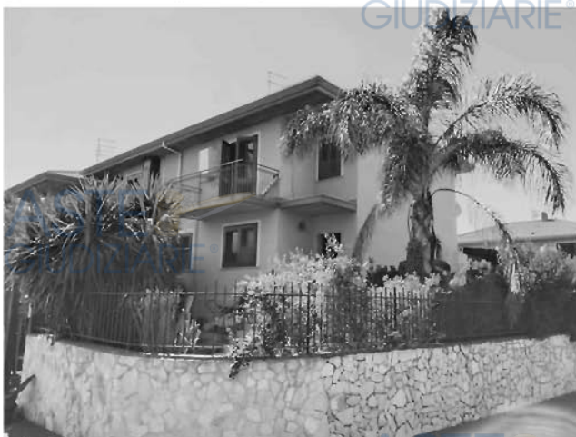
Figura 1- Visualizzazione del prospetto nord-ovest dell'immobile oggetto di perizia
