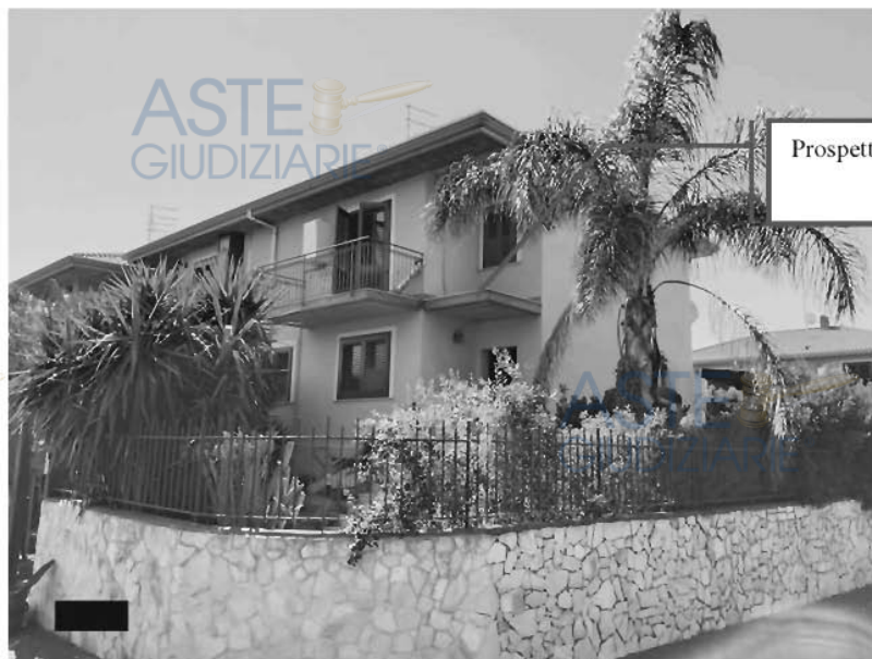
Figura 7- Visualizzazione del fabbricato lungo il prospetto nord-ovest
