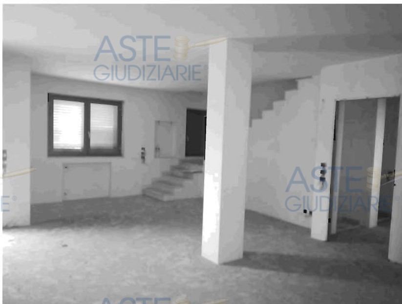
Figura 157- Visualizzazione dell'ampio vano posto a piano terra dell'immobile contraddistinto con il sub. 35
