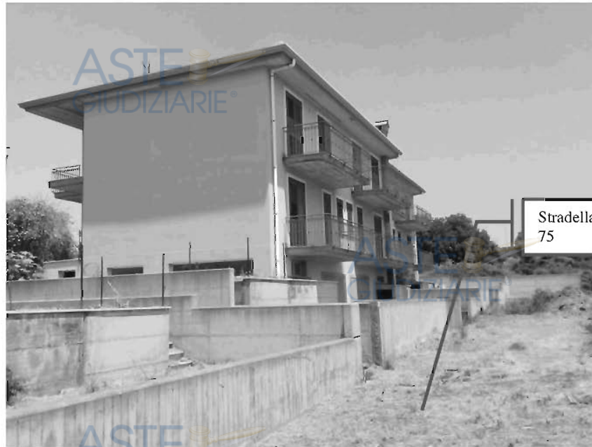
Figura 149- Visualizzazione della stradella ancora al rustico contraddistinta con il sub. 75 e posta a sud
