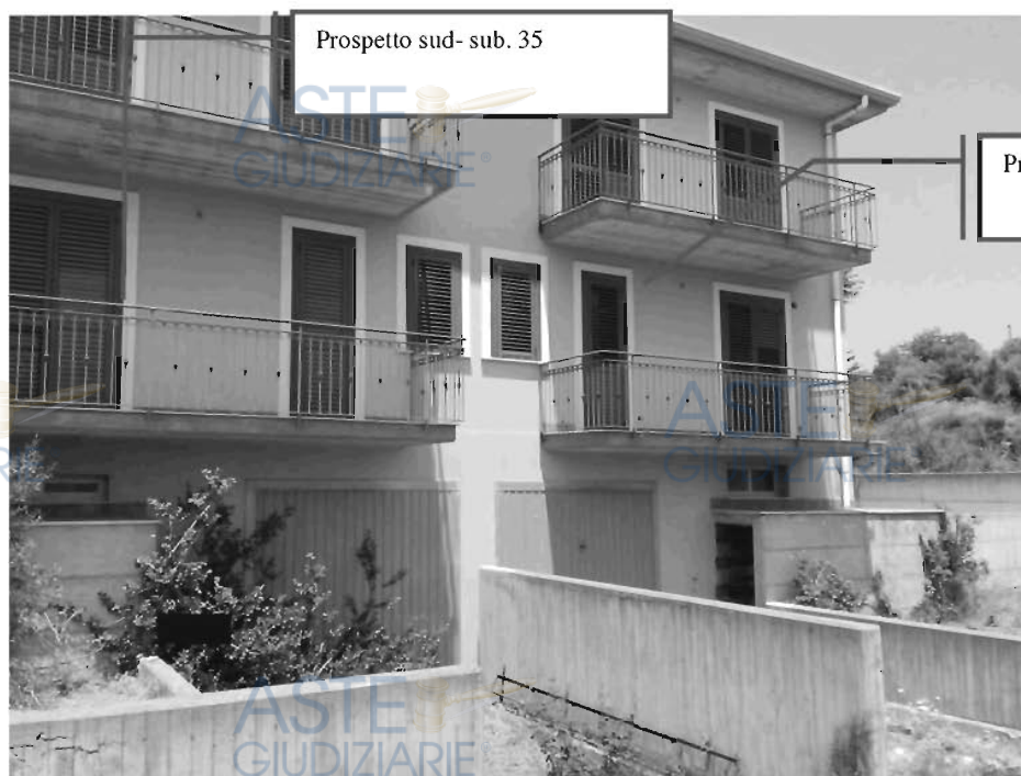
Figura 178- Visualizzazione del fabbricato lungo il prospetto sud
