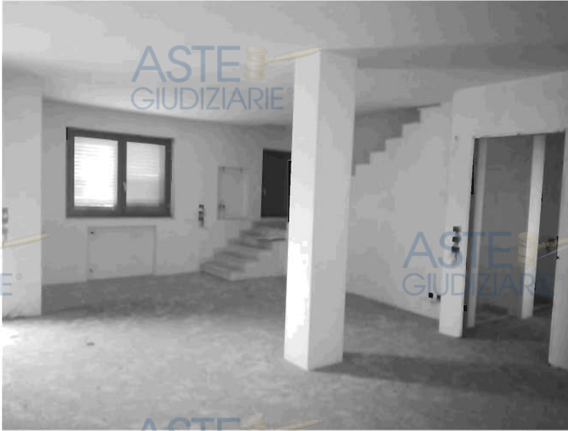
Figura 188- Visualizzazione dell'ampio vano posto a piano terra dell'immobile contraddistinto con il sub. 36
