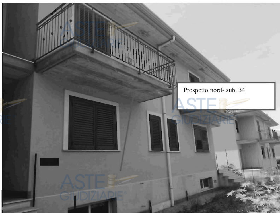
Figura 111- Visualizzazione del fabbricato lungo il prospetto nord
