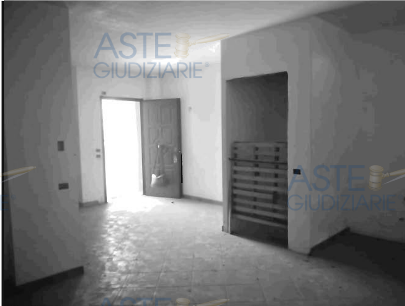
Figura 122- Visualizzazione dell'ampio vano posto a piano terra dell'immobile contraddistinto con il sub. 34
