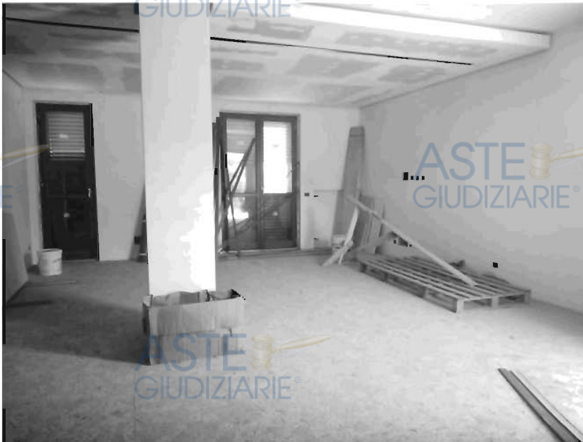
Figura 87- Visualizzazione dell'ampio vano posto a piano terra dell'immobile contraddistinto con il sub. 33
