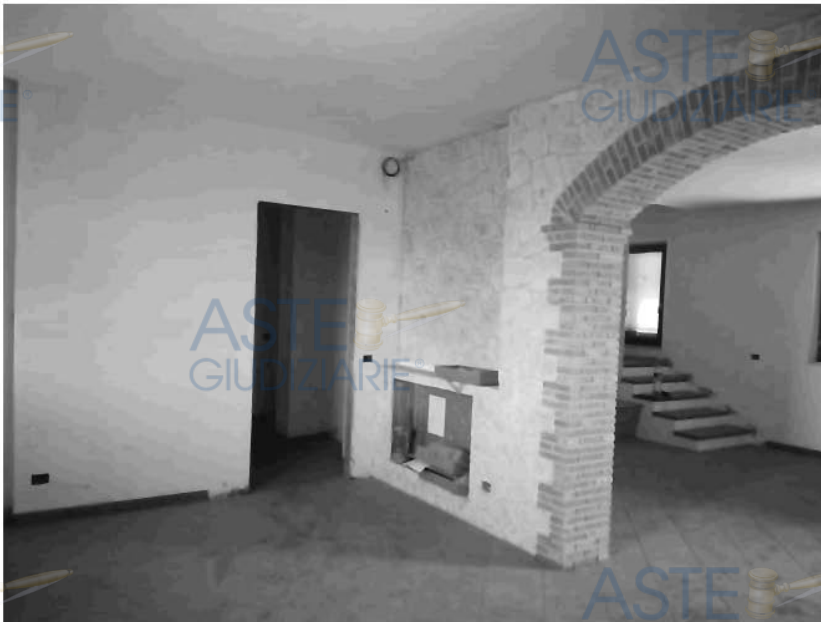
Figura 52- Visualizzazione dell'ampio vano posto a piano terra dell'immobile contraddistinto con il sub. 32
