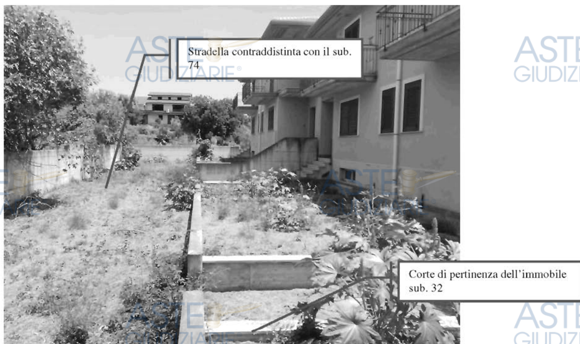
Figura 46- Visualizzazione della situazione a nord dell'immobile contraddistinti con il sub. 31
