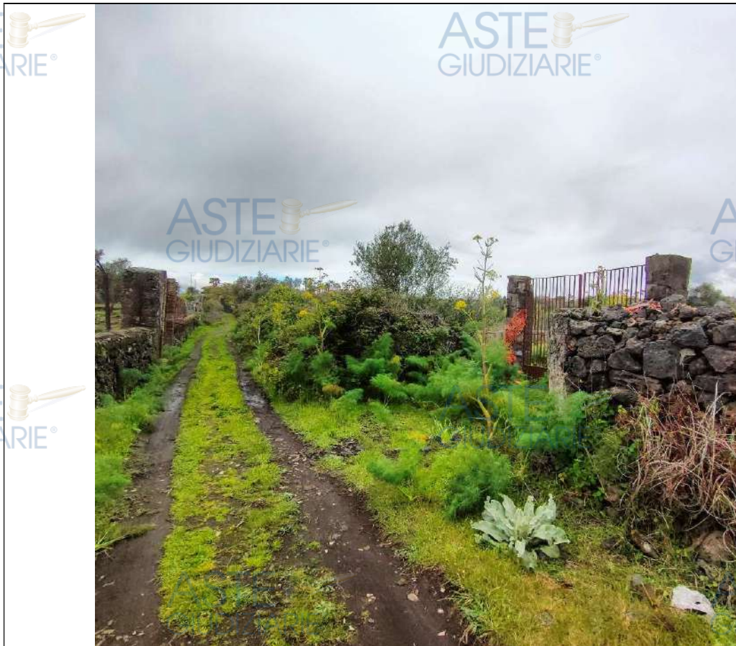
Foto4 Cancello di ingresso dalla via Marretti s.n. Mascalucia (CT) – Cespite N.C.T. foglio 13 p.lla 210
