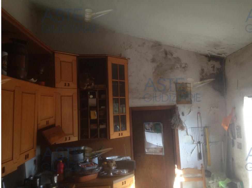
Figura 32- Visualizzazione dell'ambiente cucina posto al piano secondo, delle condizioni di ammaloramento dei soffitti e la visualizzazione della porta di accesso al sottotetto
