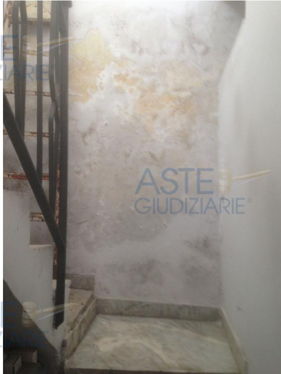
Figura 30- Visualizzazione delle condizioni di ammaloramento degli intonaci del vano scala lungo il confine nord a causa delle ingenti infiltrazioni d'acqua
