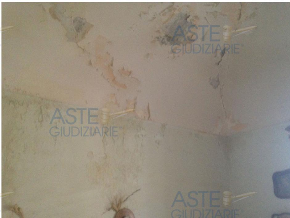
Figura 23- Visualizzazione delle condizioni di ammaloramento da infiltrazione d'acqua proveniente dalla copertura, del soffitto del vano posto ad est dell'immobile a piano primo
