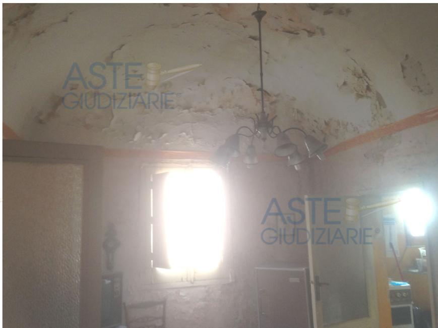
Figura 26- Visualizzazione delle condizioni di ammaloramento dei soffitti del vano centrale destinato a soggiorno, dell'immobile a piano primo, a seguito infiltrazioni d'acqua provenienti dalla terrazza
