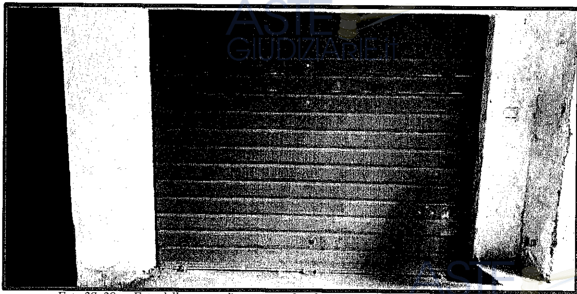
Foto 27, 28 - Foto della rampa di accesso ai locali garage e della saracinesca di ingresso al garage individuato dal sub 25
