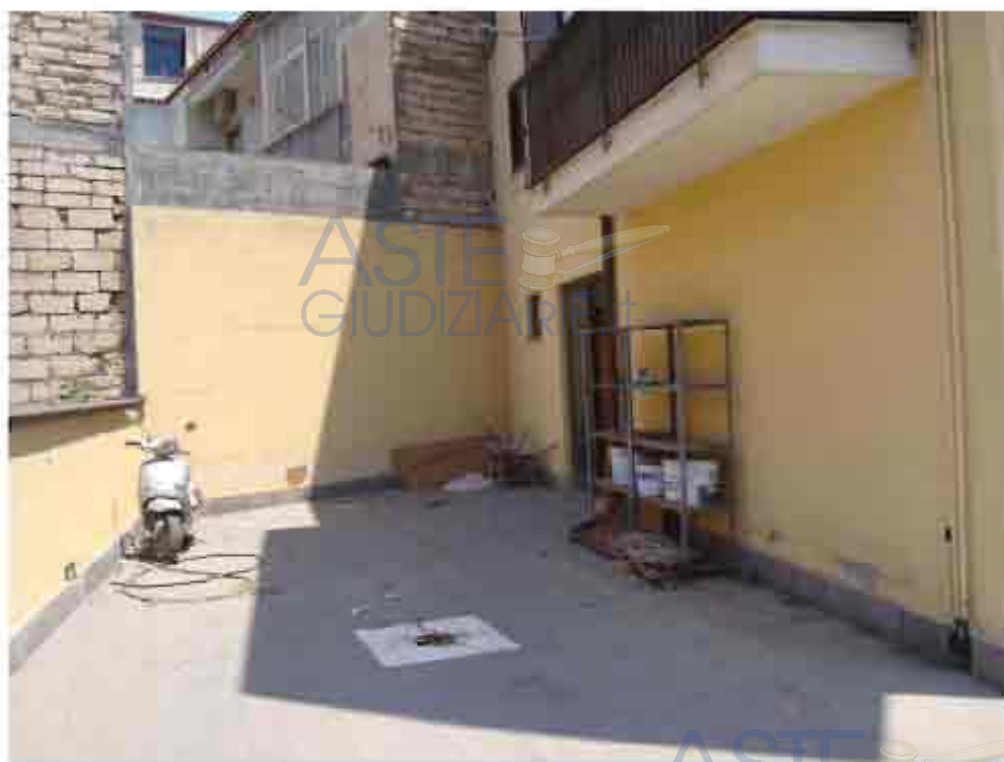
Foto 4 – Lotto 5 - Ingresso garage - Prospetto lato Ovest
