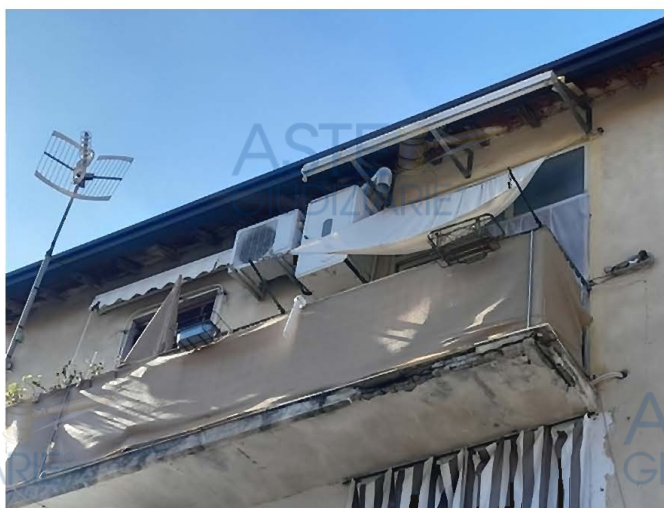
Vista del ballatoio su prospetto
