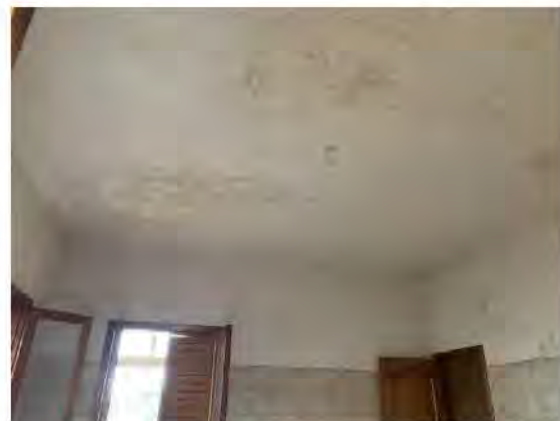
Alcuni esempi di patologie da umidità riscontrate
