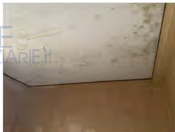
Alcuni esempi di patologie da umidità riscontrate
