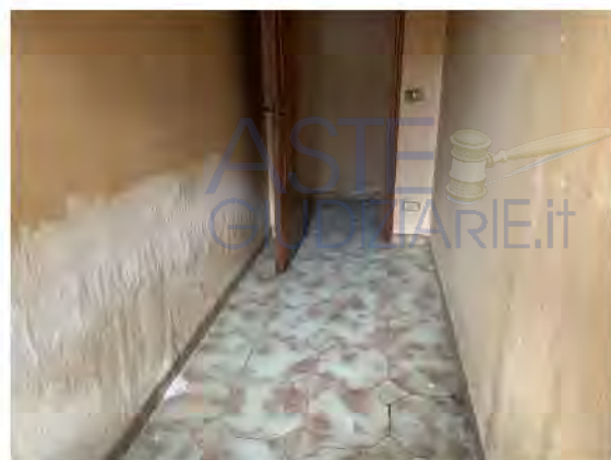
Alcuni esempi di patologie da umidità riscontrate
