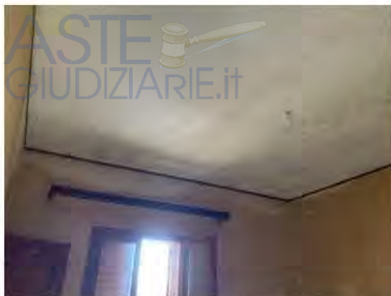
Alcuni esempi di patologie da umidità riscontrate
