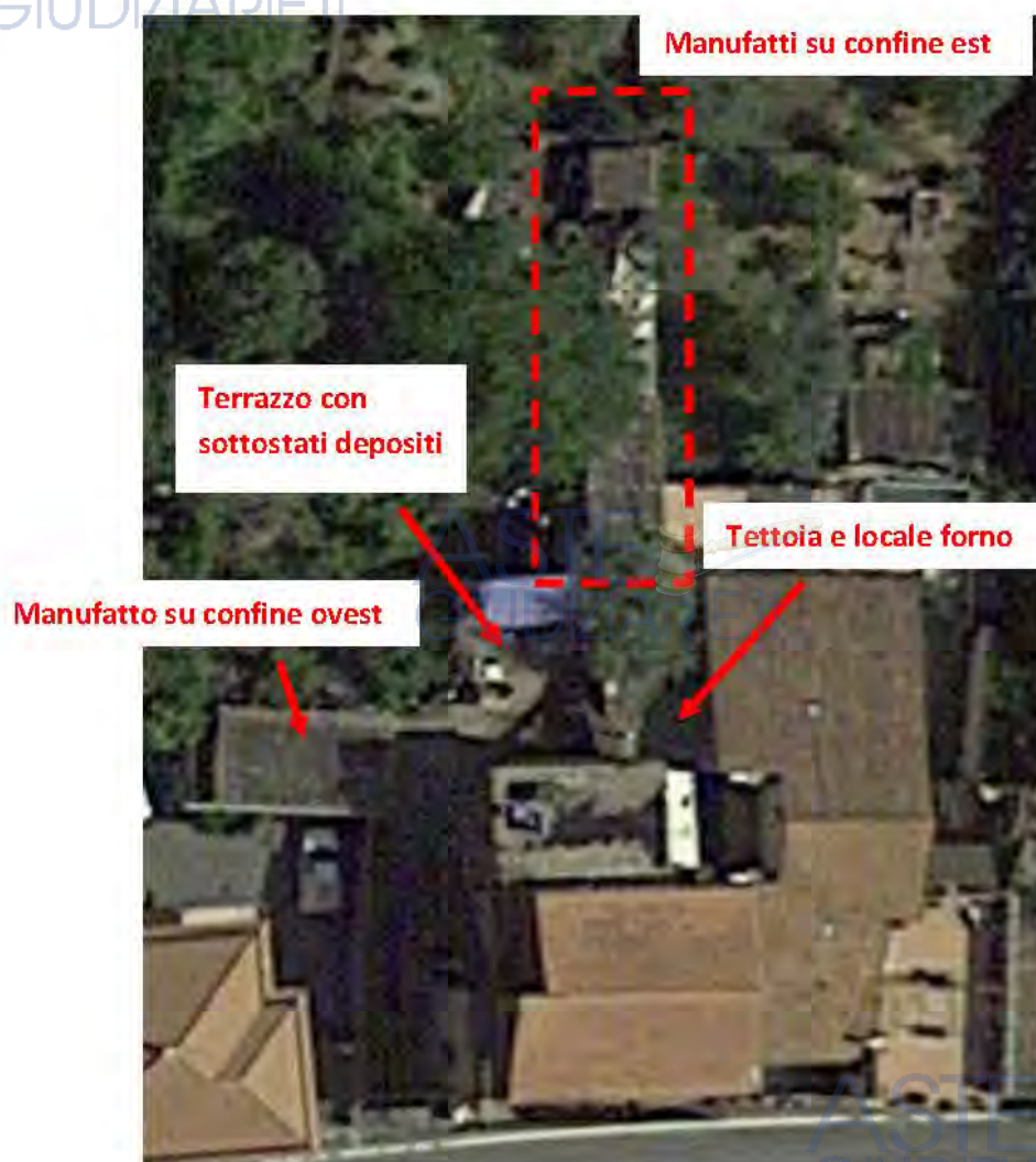
Abusi in corrispondenza del sub.1
