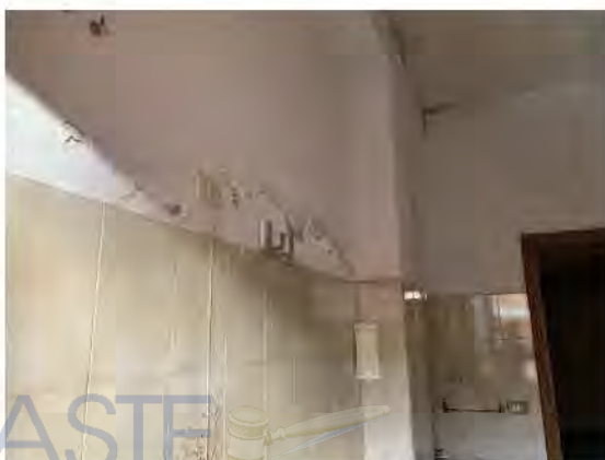
Alcuni esempi di patologie da umidità riscontrate
