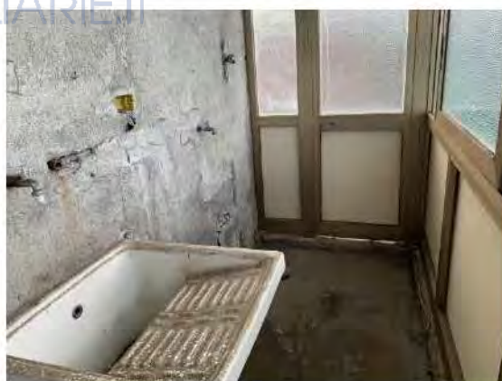
Dettagli interni della veranda porzione a nord dove sono presenti attacchi idrici e scarico
