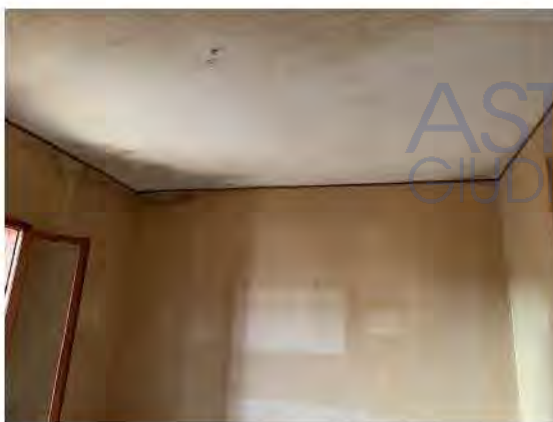
Alcuni esempi di patologie da umidità riscontrate
