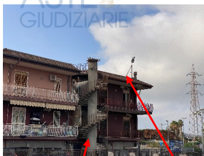
Scala C di accesso al piano secondo ove è ubicato il lastrico
