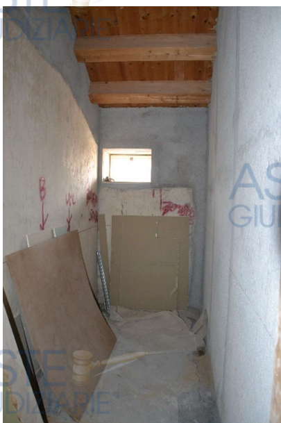
Vista wc Sub 41
