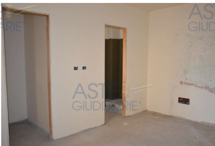
Vista interna sub 24 piano secondo
