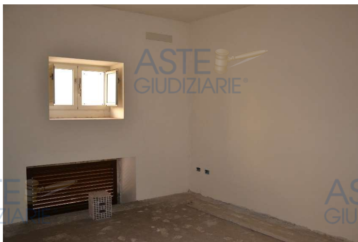
Vista interna sub 23 Piano secondo
