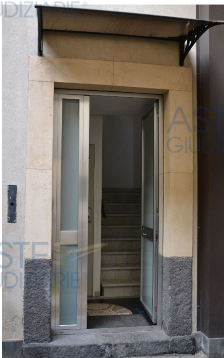
Vista ingresso vano scala
