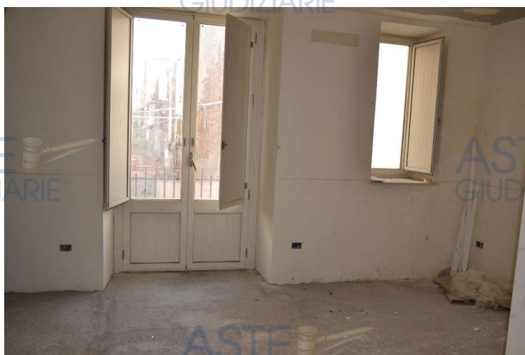
Vista interna sub 24
