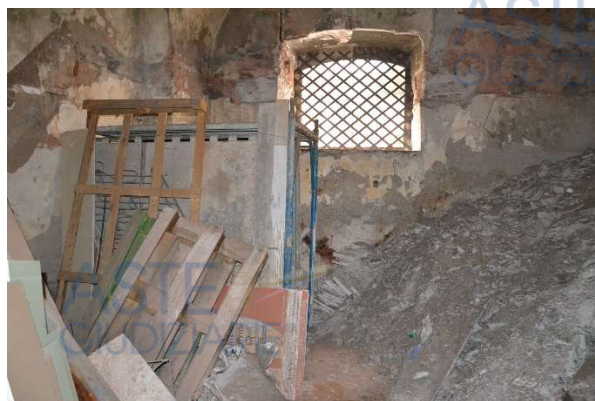
Vista interna SUB 46 ingresso androne
