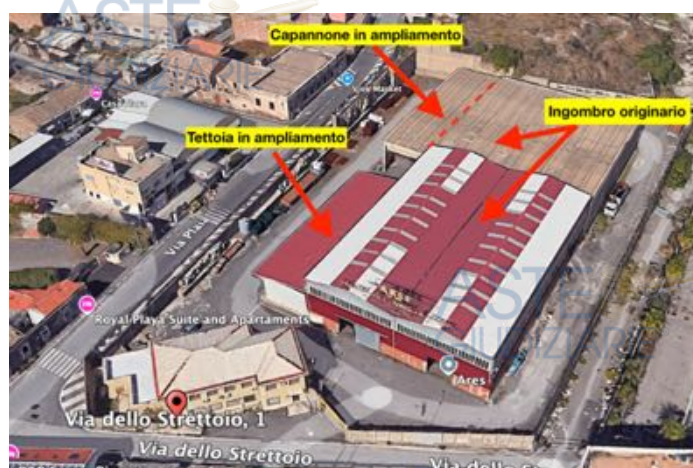
Immagine 2 – Vista sul capannone ampliato
