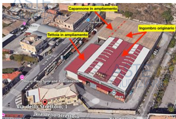
Immagine 1 – Vista sul capannone ampliato
