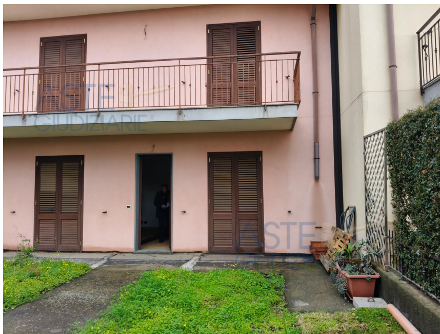
Figura 1- Visualizzazione dell'immobile oggetto della presente perizia
