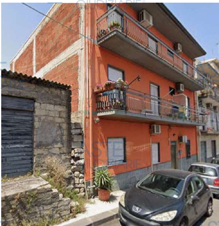
Foto 2 prospetto su via della Lucciola – vista di tre quarti
