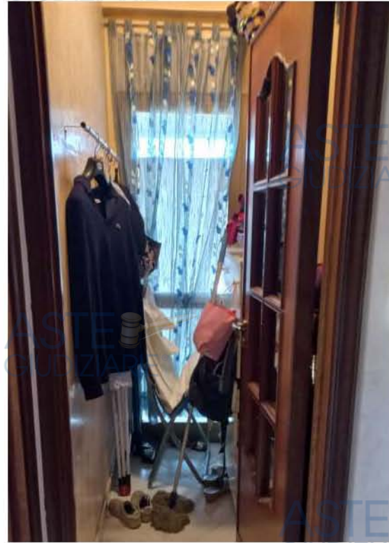
Foto 1: Individuazione dell'apertura realizzata nel locale ripostiglio
