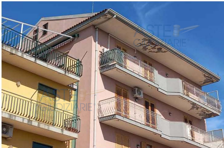
Foto 9: Rappresentazione prospetto lato Est come da sopralluogo
