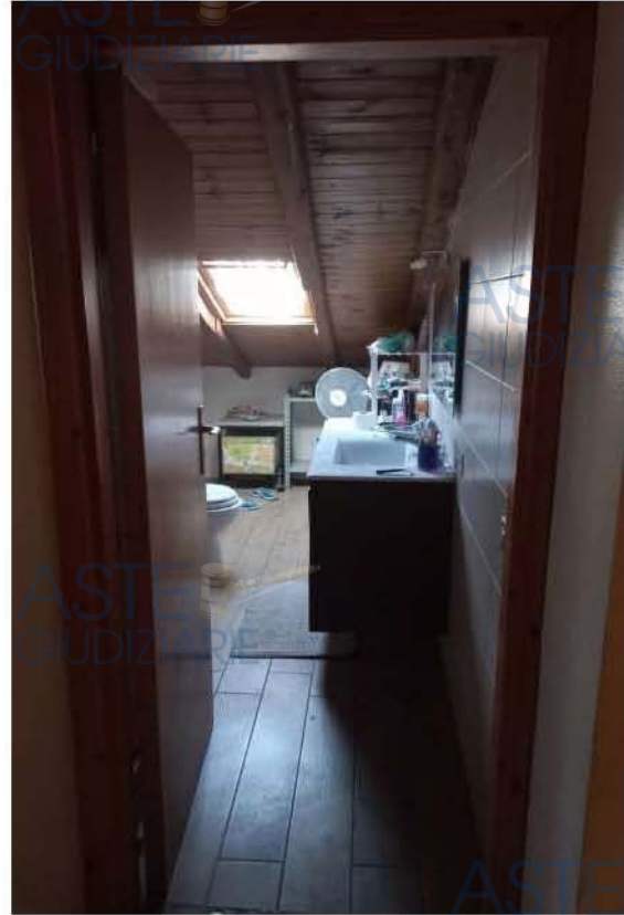
Foto 5: Individuazione del bagno presente nel locale sottotetto
