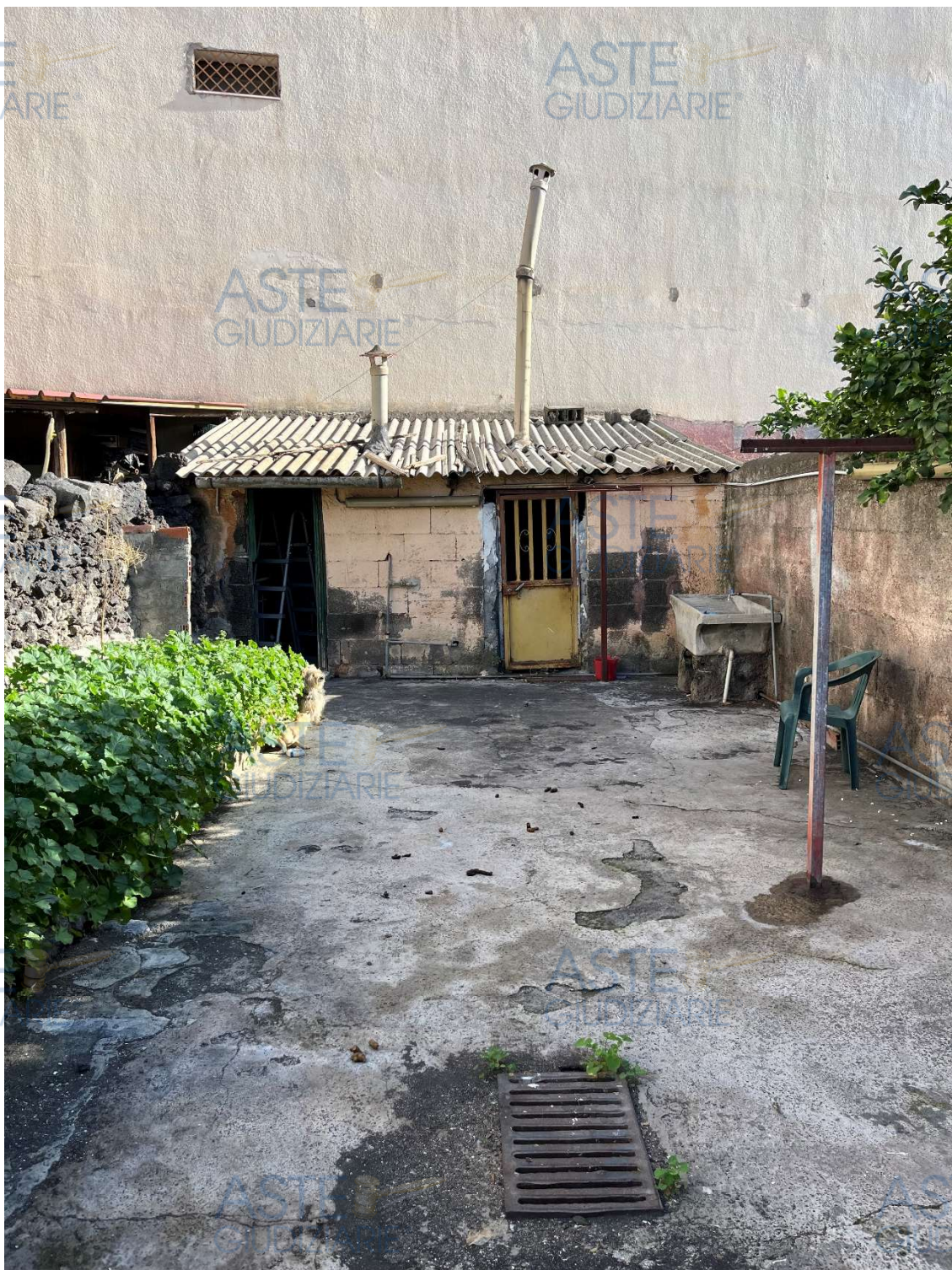
Foto 17. Vista della porzione di cortile e dei due locali facente parti della particella
