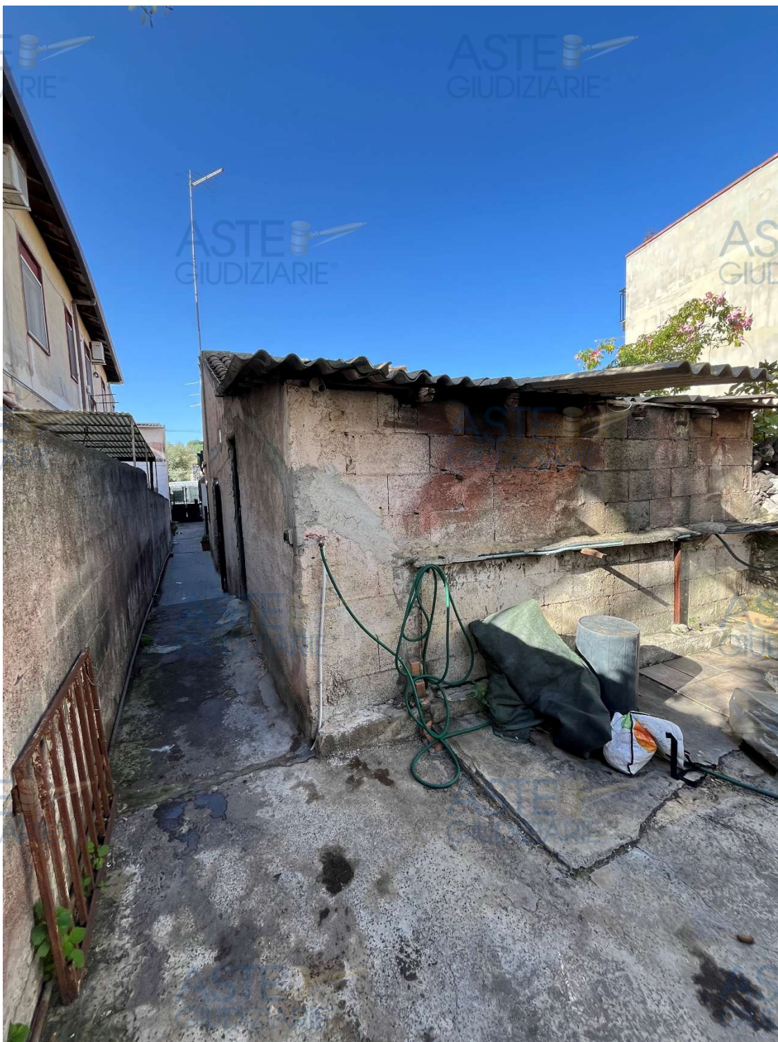
Foto 16. Vista di una porzione di cortile
