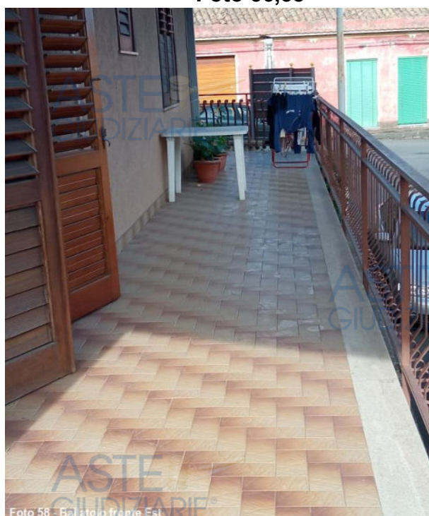
Foto 58 - Ballatoio fronte Est
