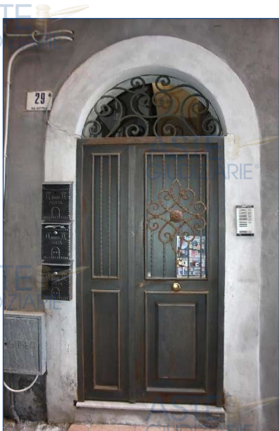
Foto 7 - Portone ingresso via Sottile n.29
