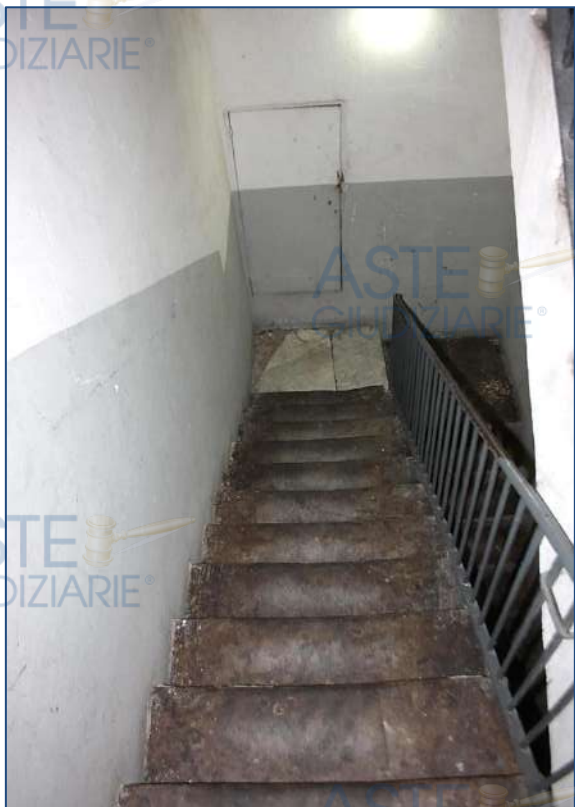
Foto 11 - Scala d'ingresso verso il ripostiglio
