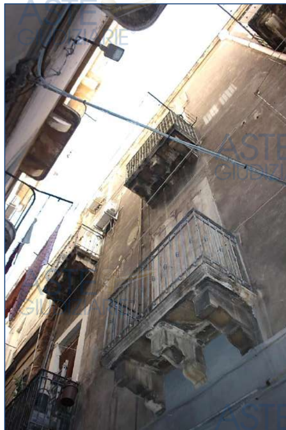
Foto 4 - Balconi dell'unità Immobiliare di via Sottile
