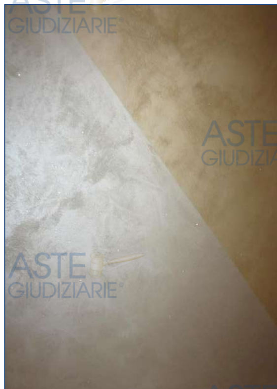
Foto 56 - Finitura parete camera da letto Piano sottopalco
