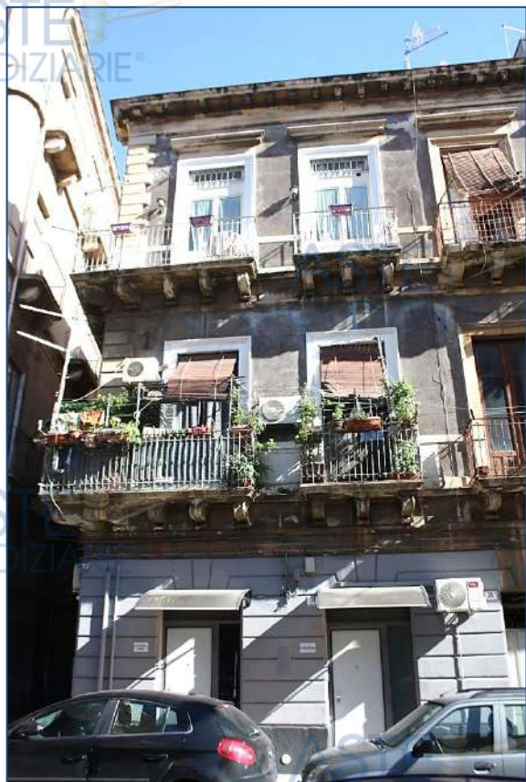
Foto 3 - Vista dell'edificio da via Porta di Ferro
