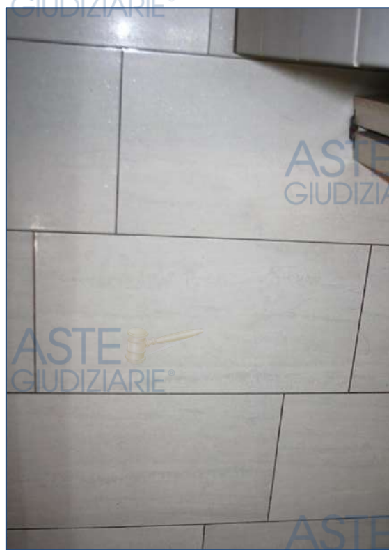
Foto 52 - Pavimentazione zona pranzo- cucina n.2
