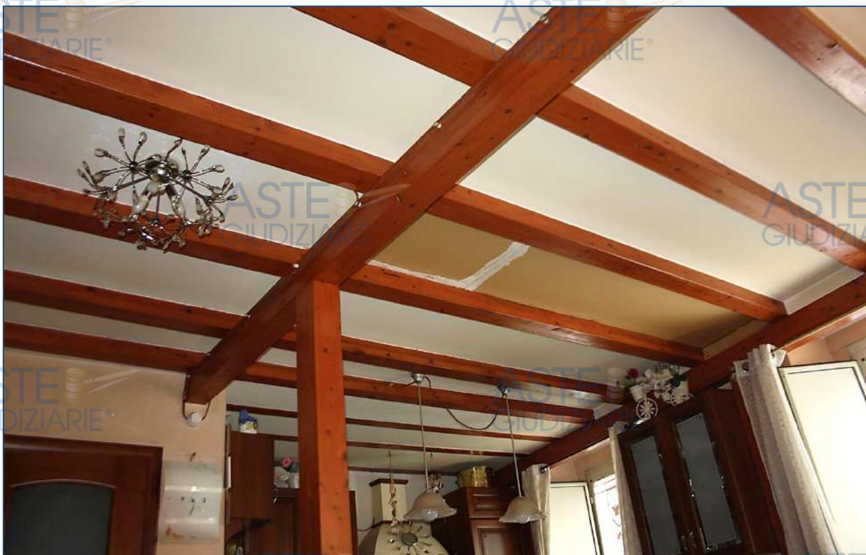
Foto 37 - Struttura di sostegno del solaio del soppalco (travi e pilastri in legno)
