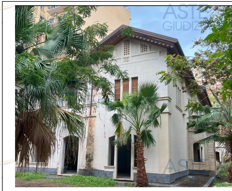
Vista esterna villino
