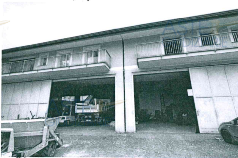
Foto 1 – Vista sul prospetto modificato
