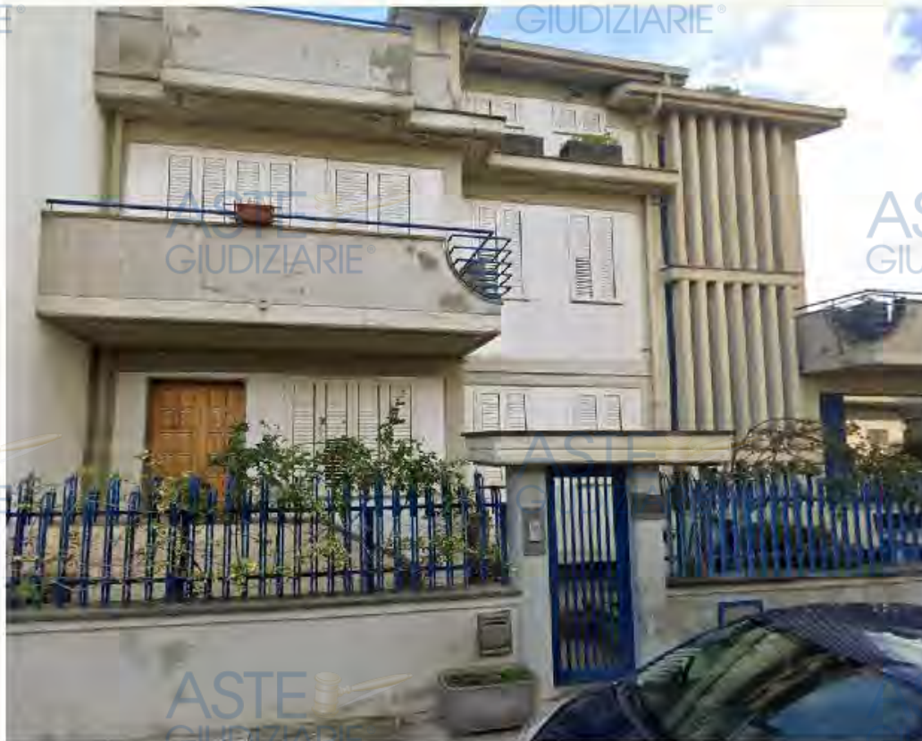
Vista frontale dell'immobile
