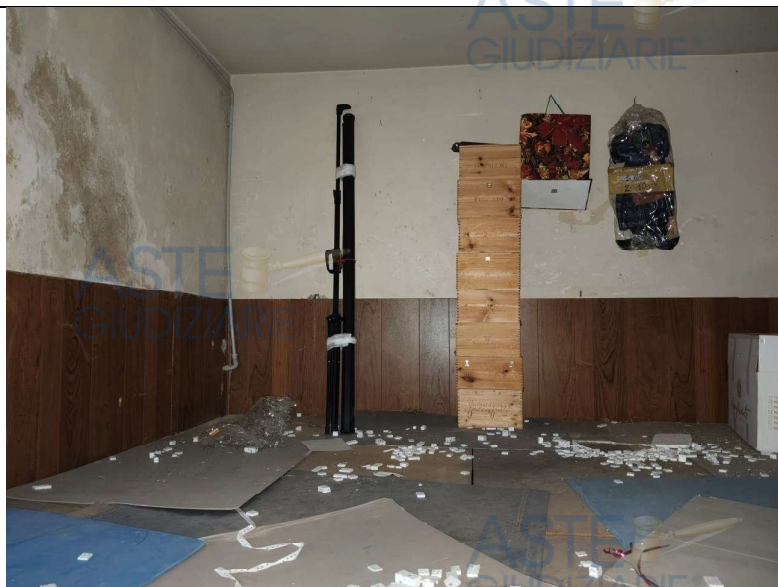
Foto n. 5- Visualizzazione del piano soppalcato
