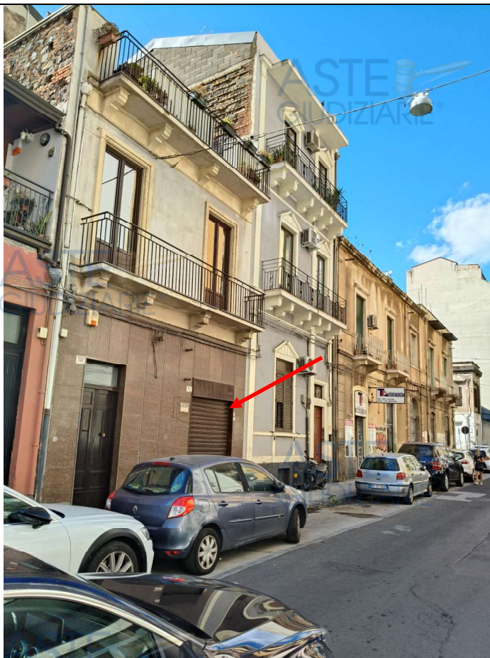
Foto n. 1- Visualizzazione dell'ingresso all'immobile dalla Via Pubblica
