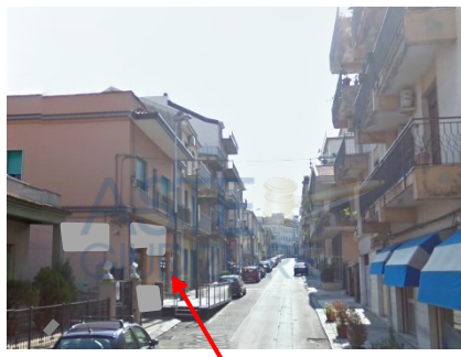
Vista del fabbricato dalla via Vittorio Alfieri
