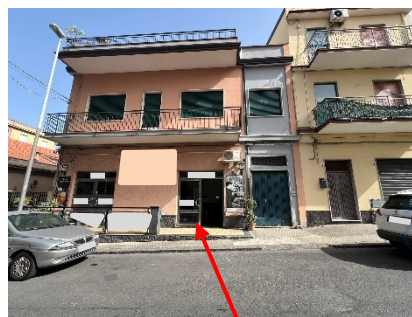
Ingresso alla bottega al piano terra dalla via Vittorio Alfieri n. 69
