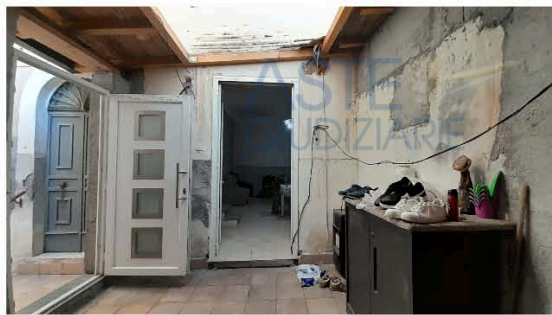
Ingresso al piano terra su cortile
