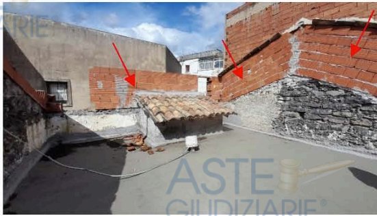
Lastrico solare - Stato di fatto
