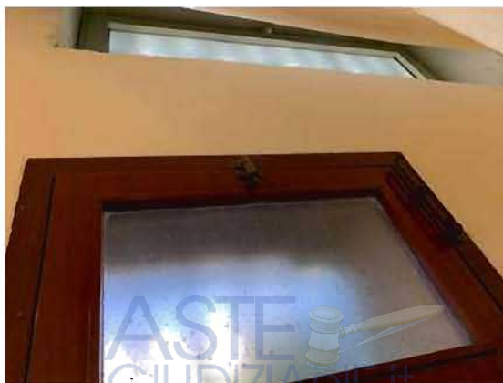
Tipologia infissi esterni in corrispondenza dell'originario wc che insisteva ad ovest
