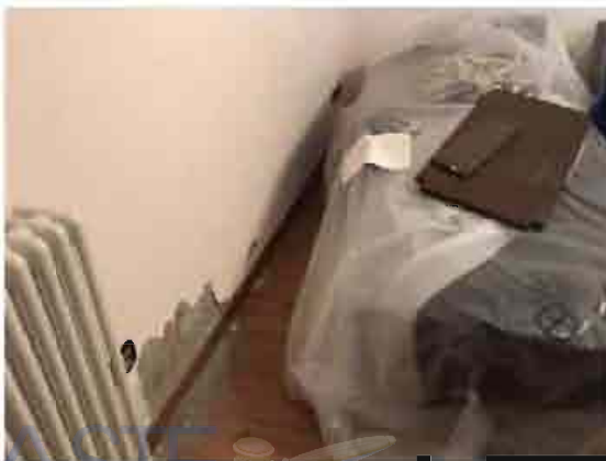
Vista stati patologici da umidità di risalita e muffe a soffitto
