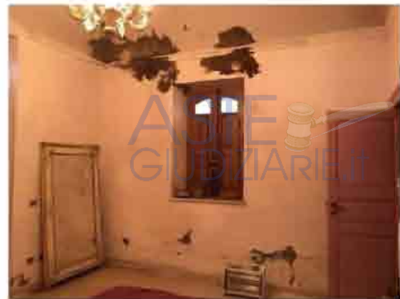
Vista stati patologici da umidità di risalita e muffe a soffitto
