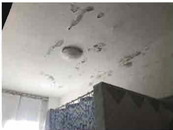
Patologie da umidità e condensa wc
