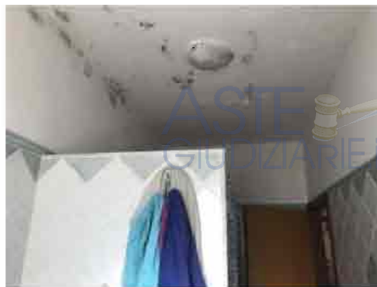
Patologie da umidità e condensa wc
