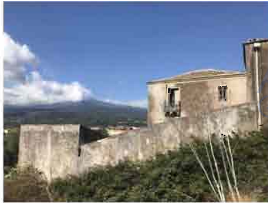
Vista esterna del fabbricato part.103
