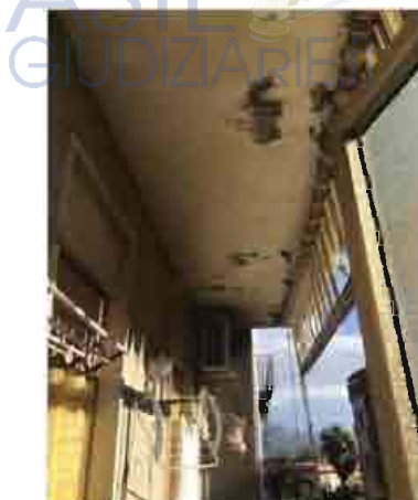
Patologie da umidità sottobalatoi dei balconi a est ed ovest
