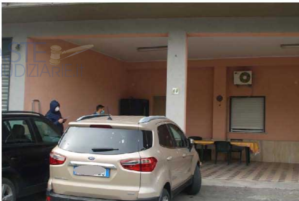
Vista del portico e dell'ingresso della bottega (piano Terra)
