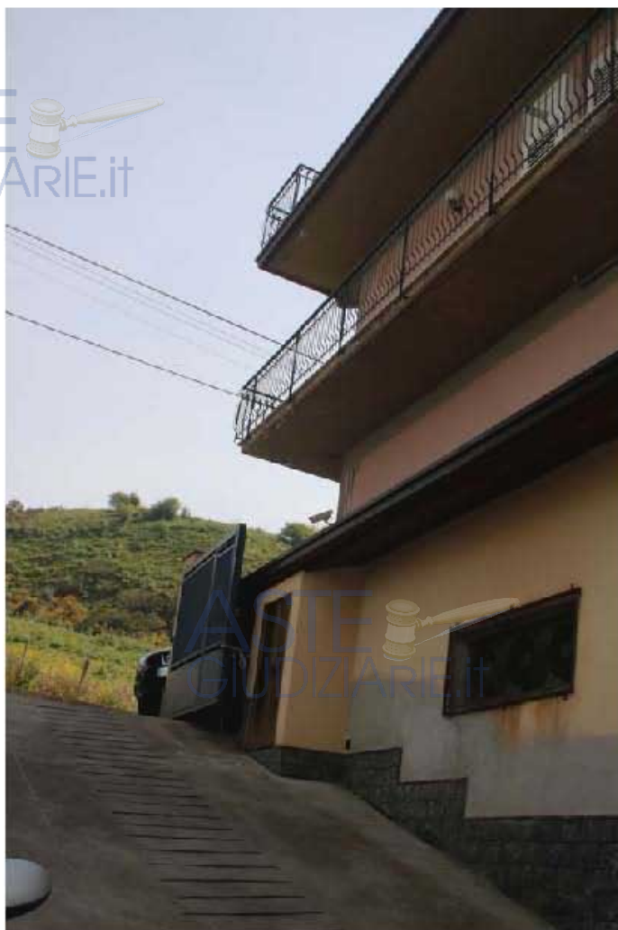
Stradella di accesso al caseificio
