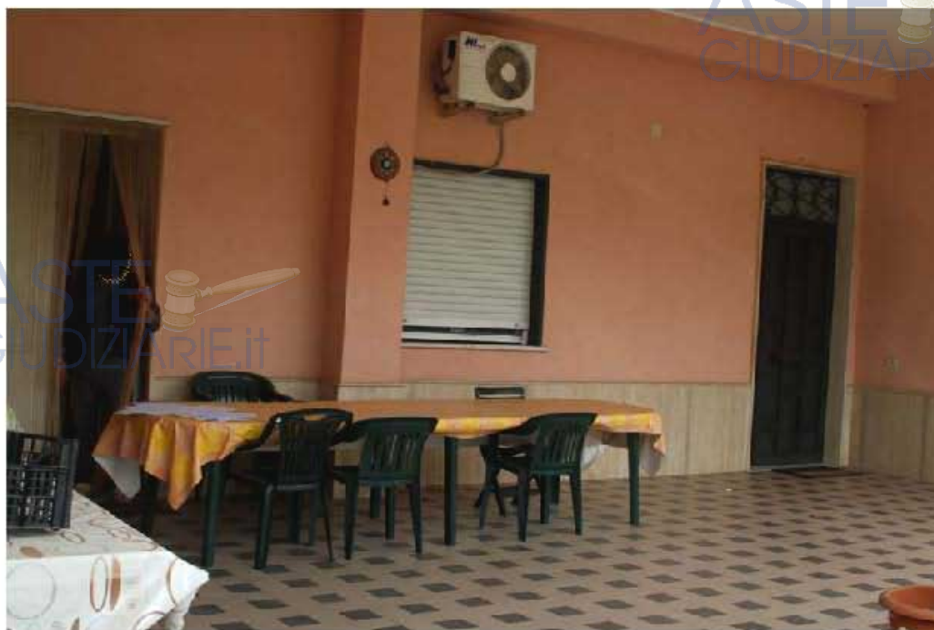
Vista dell'ingresso del vano scala (a destra) e di una finestra sul portico dell'appartamento a piano terra
