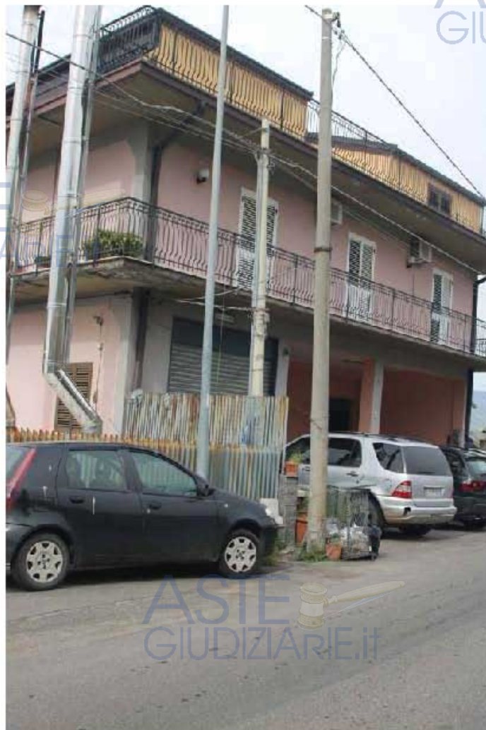
Prospetto principale dell'edificio di cui fa parte l'appartamento a piano terra
