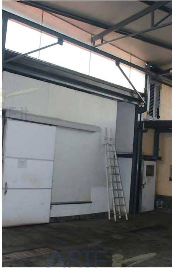
Porta di ingresso alle celle frigorifere e locali di stoccaggio
