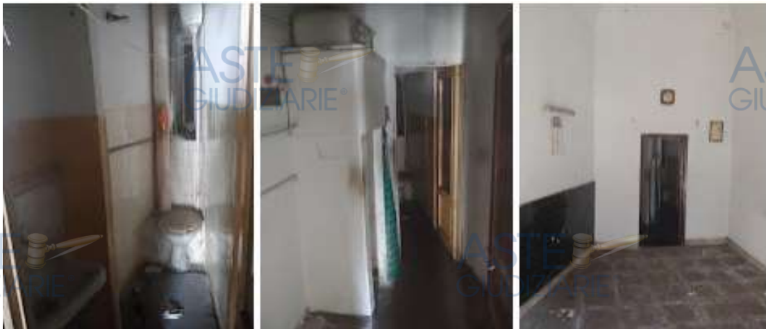
Locale con accesso dal civico 242 E vano antistante e vano retrostante
