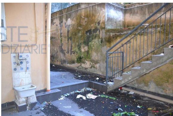
Vista del cortile lato Ovest
