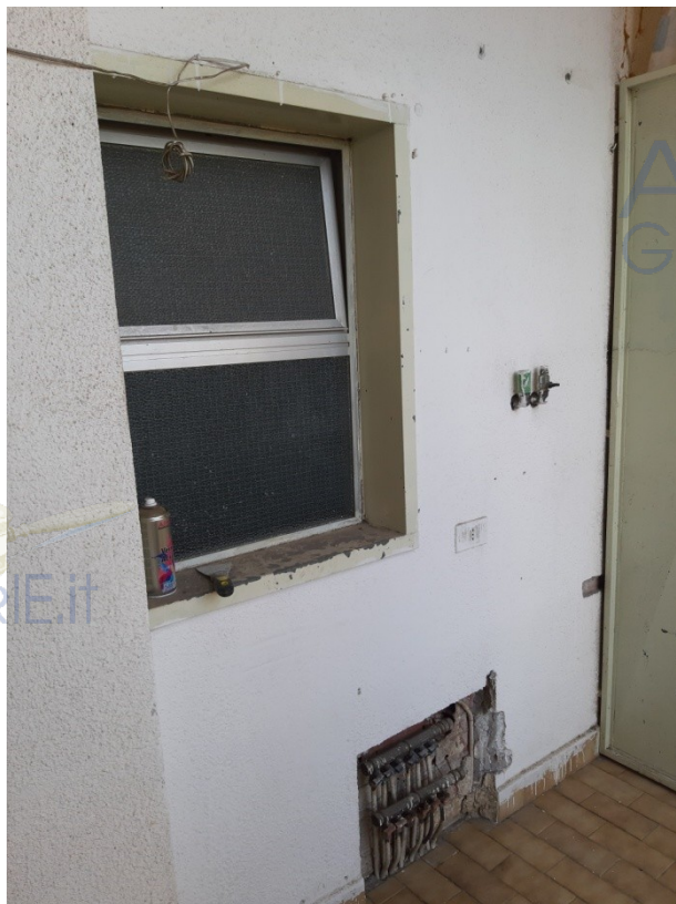
Foto 16 – Batteria dei collettori sul ballatoio della cucina
