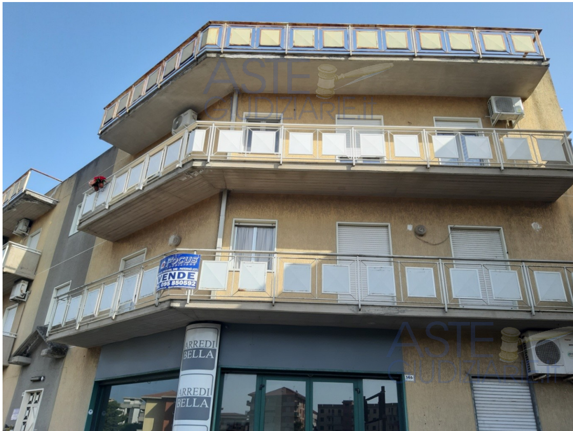
Foto 1 – Edificio condominiale sito in Corso Italia 148, Paternò (CT)
