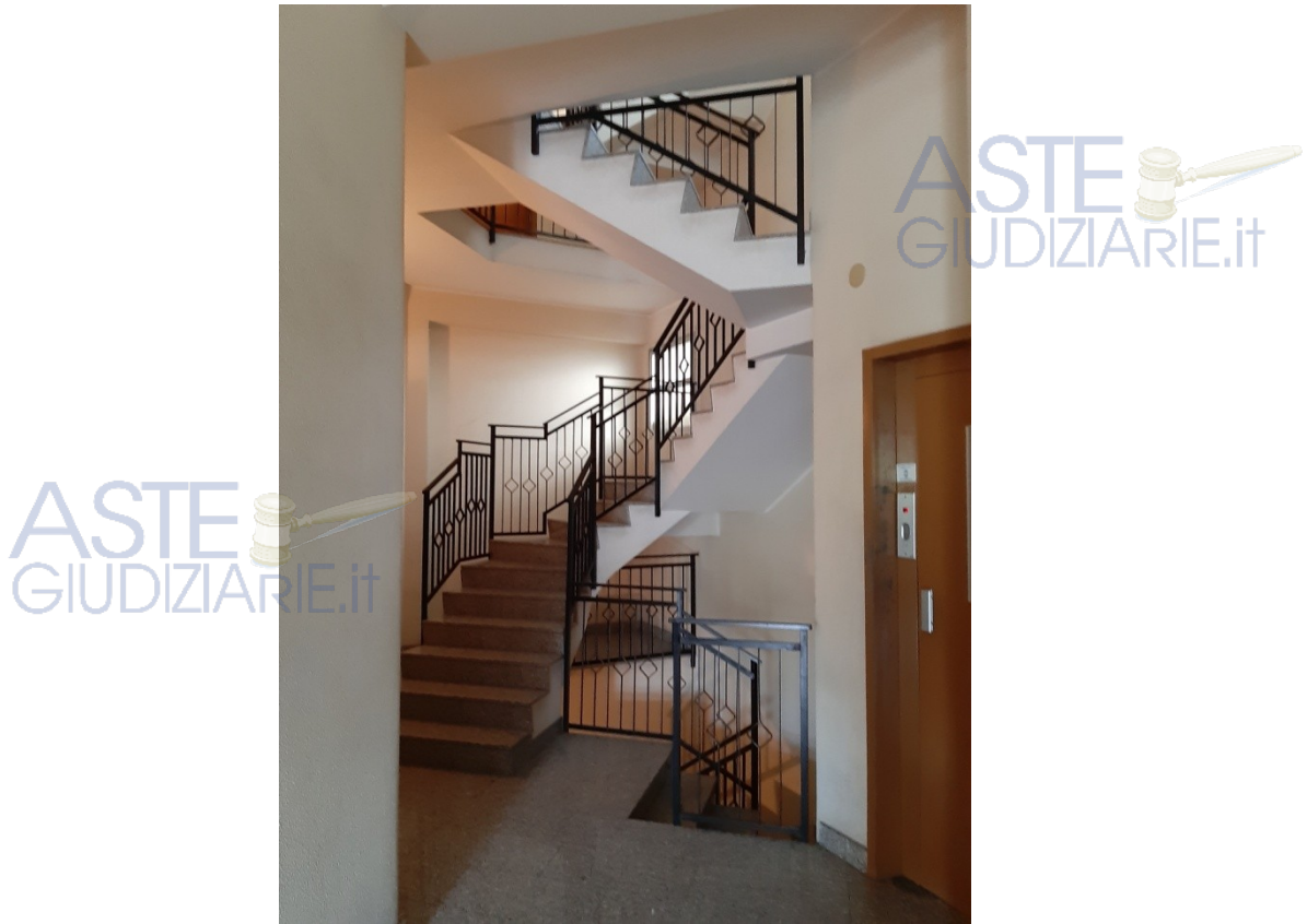
Foto 3 – Scala di accesso ai piani dell'edificio
