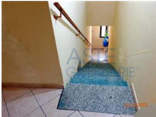
scala comune di collegamento tra P. 1 e P. 2
