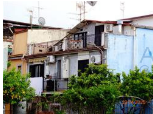
facciata nord-est fabbricato (Via Reno)
