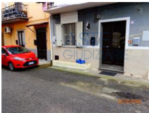
Portone ingresso fabbricato
