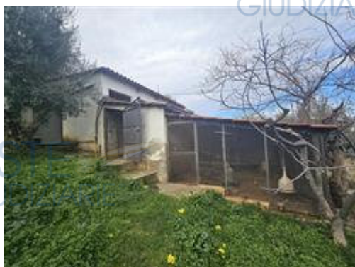
Foto 1 - Fabbricato ad uso deposito con adiacente pollaio
