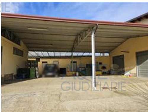
Foto 1 - Tettoia sul lato Nord-Est del capannone e facciata anteriore del locale deposito 2 (piano terra)
