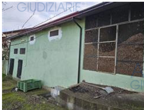
Foto 2 - Lato posteriore del locale deposito 2 (Piano seminterrato e piano terra)
