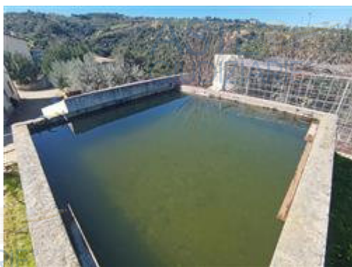
Foto 1 - Vasca di raccolta acque
