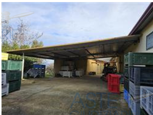
Foto 3 - Tettoia sul lato Nord-Ovest del Capannone
