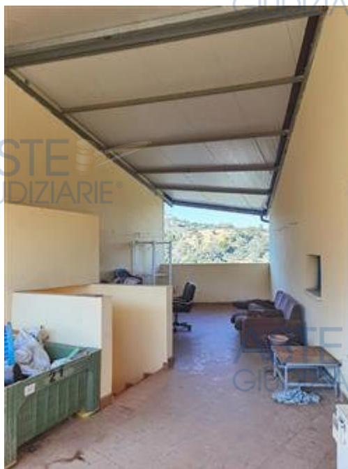
Foto 1 - Tettoia a copertura del pianerottolo/terrazzo
