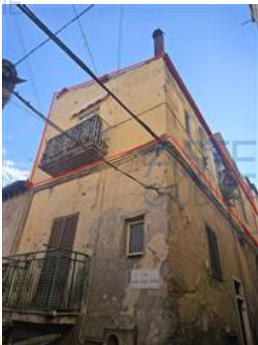
Foto 1 - Esterni con indicazione appartamento
