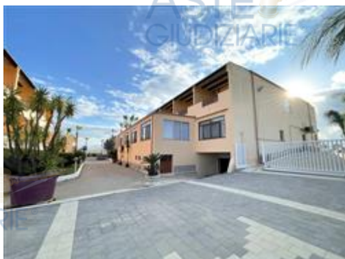
Struttura recettiva - Edificio ovest
