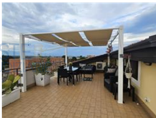
Foto 1 - Tettoia su terrazzo
