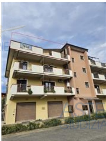
Foto 1 - Esterni con indicazione appartamento
